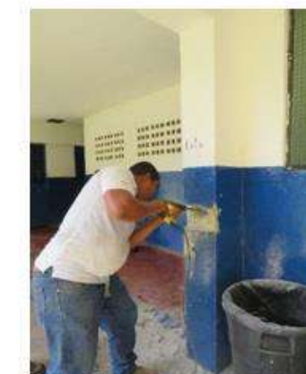
Exploración de acero de refuerzo
