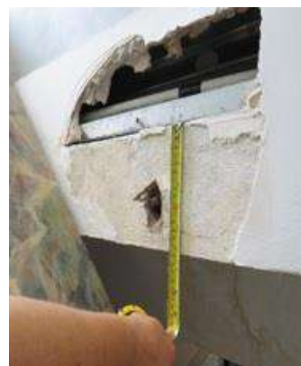
Levantamiento geométrico y mediciones de espesor de losa
