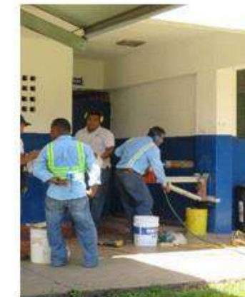
Detección de acero de refuerzo
