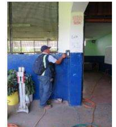
Extracciones de concreto en elementos de columnas
