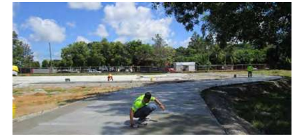
Construcción de Acera hacia la Cancha de Baloncesto en el Centro Regional de Chiriquí
