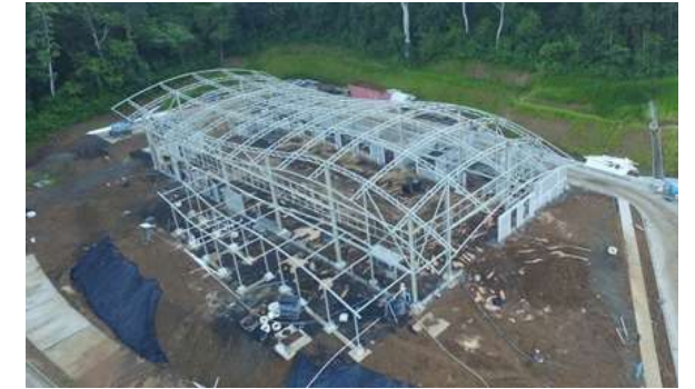
Edificio de Laboratorios Docentes
