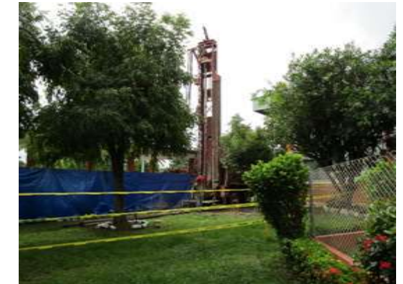
Construcción de pozo en el Centro Regional de Chiriquí
