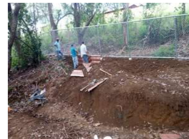
Construcción de la Cerca Perimetral, Centro Regional de Veraguas
