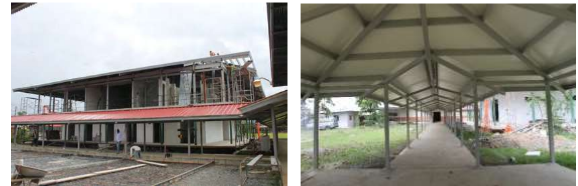
Construcción de Edificio en el Centro Regional de Bocas del Toro
