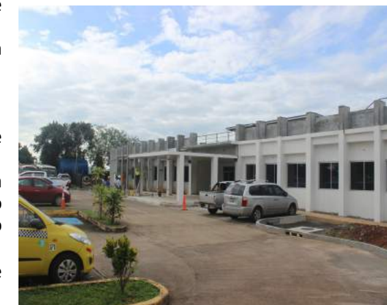
Construcción del Edificio de Aulas (I Fase) del Centro Regional de Panamá Oeste
