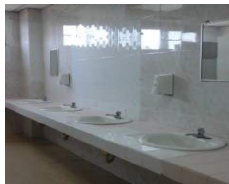
Reparación de azulejos de los baños en las diferentes Facultades.
