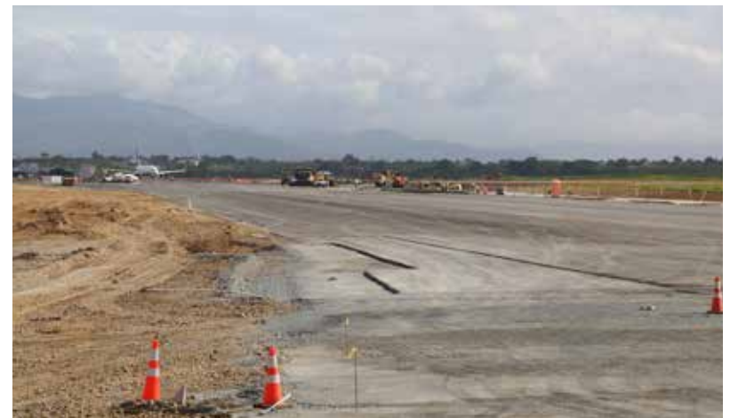
Trabajos de construcción de calle de rodaje Lima.
