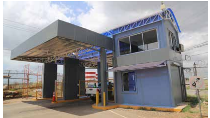
Rehabilitación de la Garita 15 que brinda acceso a los camiones que abastecen de combustible a la terminal.
