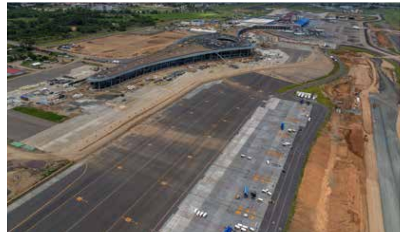
Vista aérea de la nueva plataforma de estacionamiento remoto para aeronaves.
