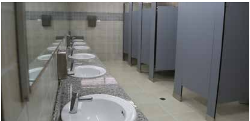
Remodelación de sanitarios en la Terminal de Carga.
