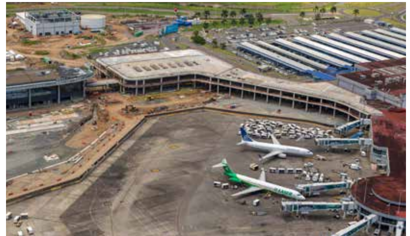
Avance de la construcción del edificio conector que une las Terminales 1 y 2
