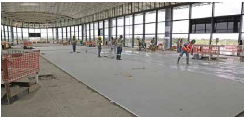
Construcción de acabados en la nueva Terminal 2.
