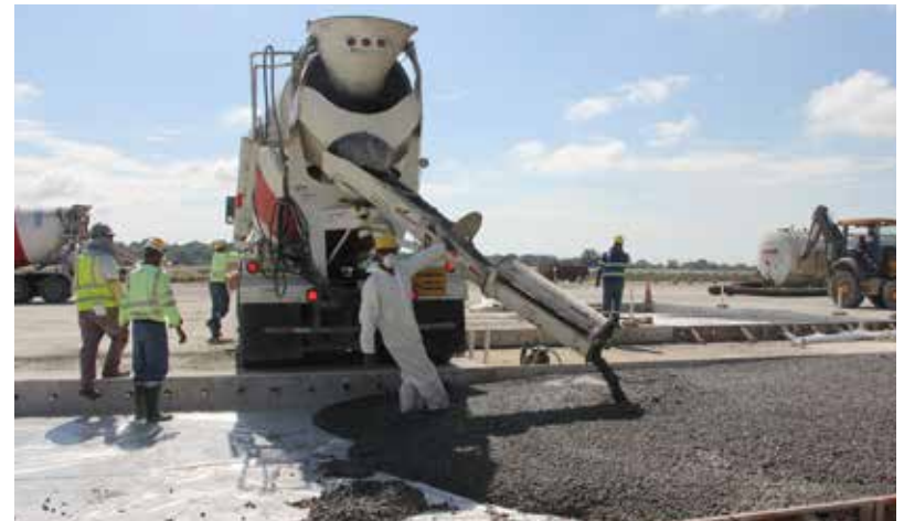
Trabajos de construcción de la plataforma en la Terminal 2.
