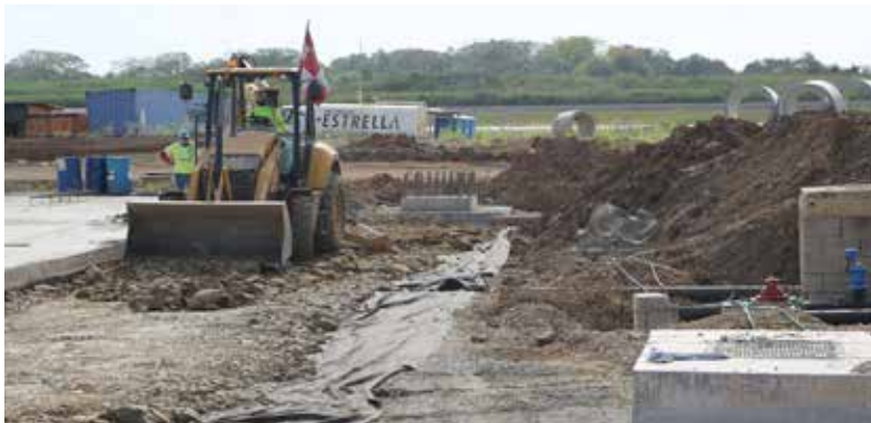
Trabajos de reubicación de infraestructuras.
