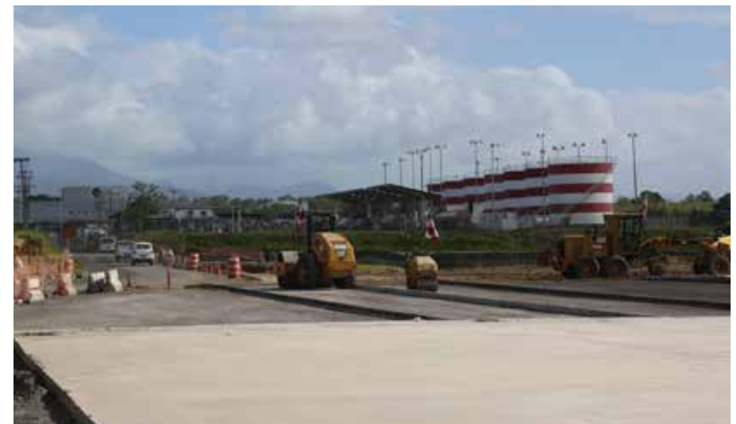
Construcción de plataforma de estacionamientos para 4 aeronaves tipo C y E.
