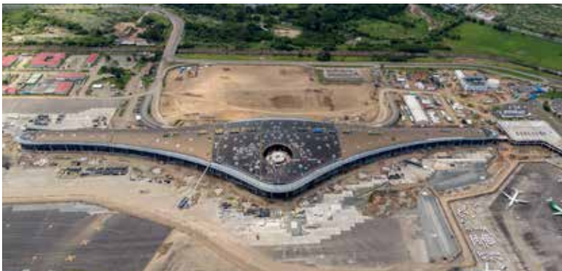
Vista aérea de la nueva Terminal 2 en construcción.
