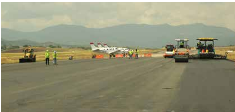
Trabajos de reconstrucción de pavimentos en calle de rodaje H.
