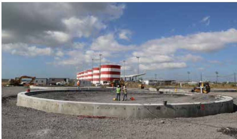
Avances de los trabajos de construcción de tres tanques de almacenamiento de combustible.
