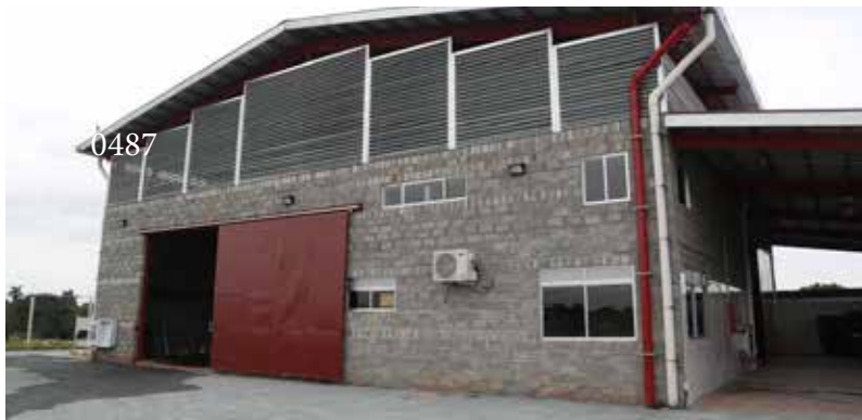
Nueva Planta de Tratamiento de Desecho Residual.
