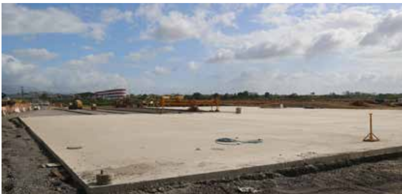
Construcción de estacionamientos para aeronaves “Código E”
