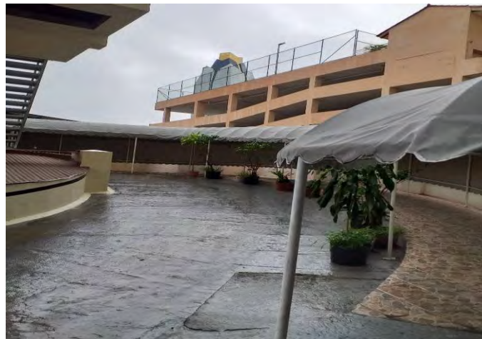
Desmonte, suministro de Tolda, en el pasillo piso N° 3 del Edificio Sede anexo, enero 2019.
