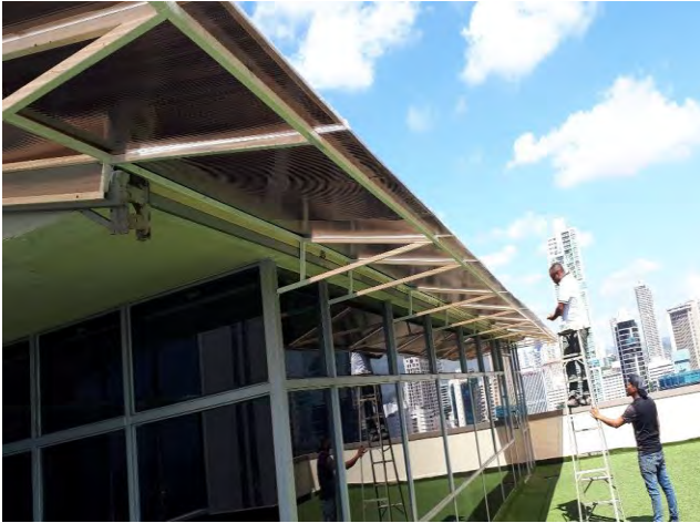
Desmonte, suministro e instalación de aleros de policarbonato, azotea Edificio Sede, enero 2019.
