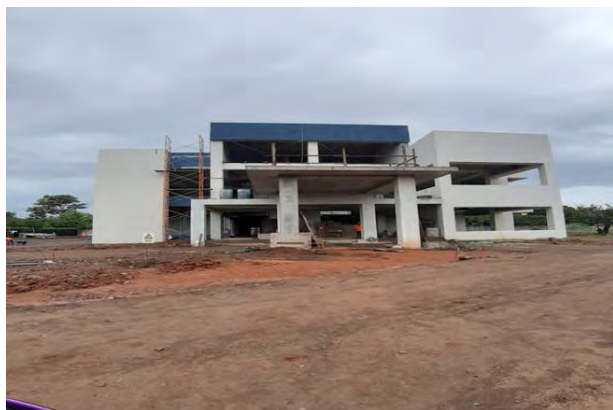
Futura sede provincial de la Contraloría General de la República en Veraguas, observa avance de obra a octubre de 2019 de un 88%
