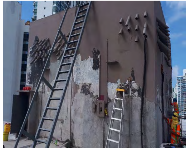
Impermeabilización de paredes perimetrales y techo del cuarto de máquina, enero 2019.
