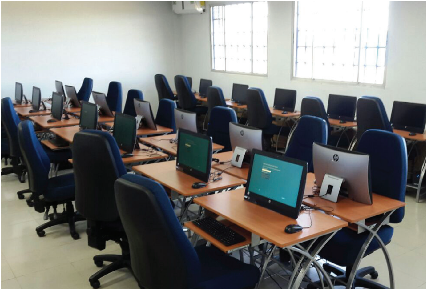
Modernización del cableado estructurado e instalación de nuevos equipos en el salón de cómputo de la AFP.
