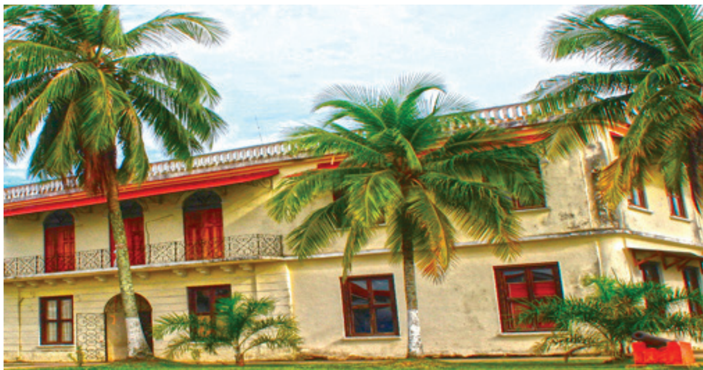
El Ministerio de Gobierno trabaja en la restauración del Palacio de la Gobernación de Bocas del Toro.
