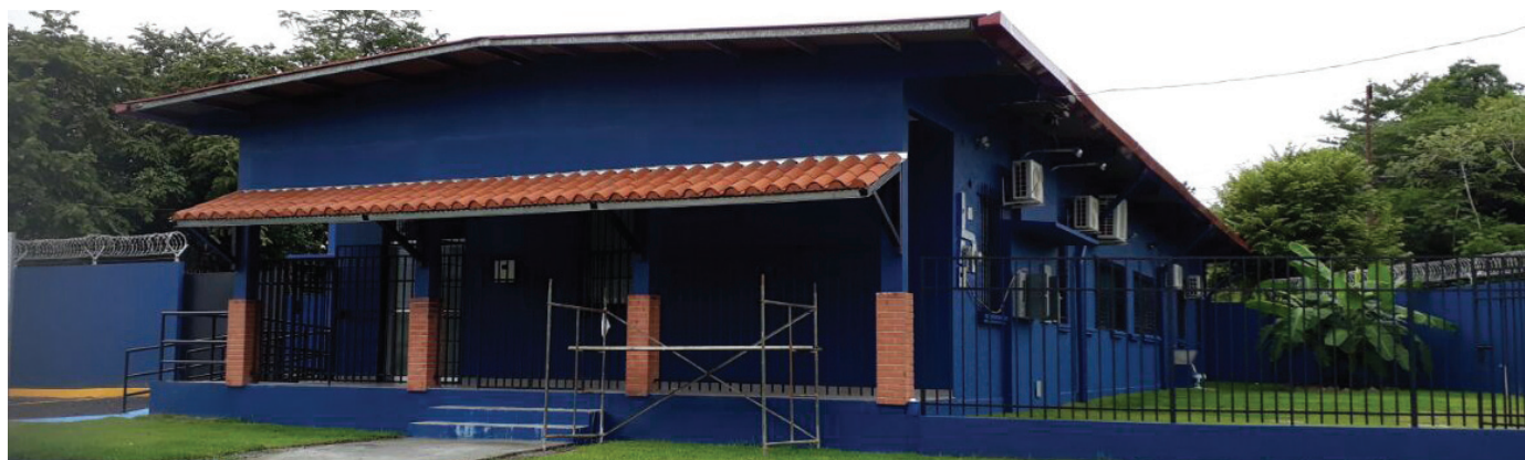
El Viceministro de Gobierno, Carlos Rubio, acompañado del Director General de Correos, Rubén Gómez, inspeccionaron el nuevo Centro de Intercambio de Despachos Postales, ubicado en Divisa, provincia de Herrera.
