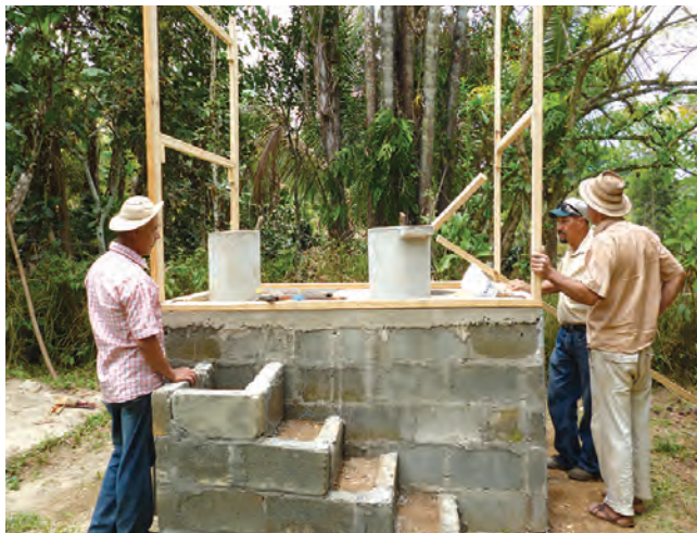
Construcción de letrinas aboneras en la provincia de Herrera.
