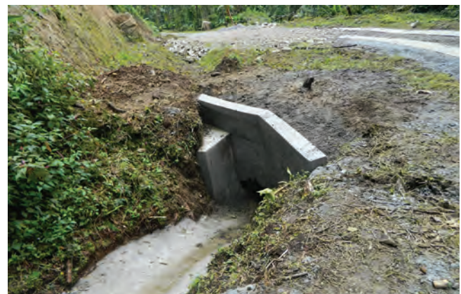
Construcción de cunetas y cabezas en PILA – Pacífico.
