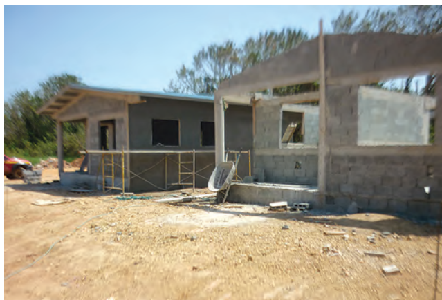
Inspección a proyecto habitacional en la provincia de Herrera.
