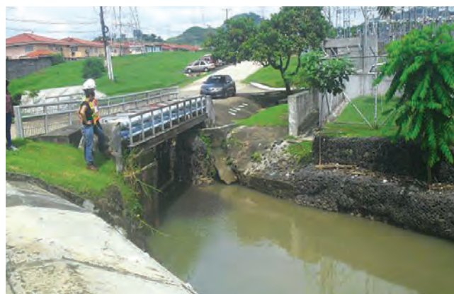
Inspección realizada al área de Condado del Rey, Panamá.
