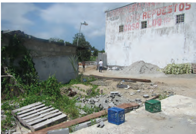
Inspección a Proyecto de construcción Local Comercial y residencia en Paso Blanco, Panamá Este.
