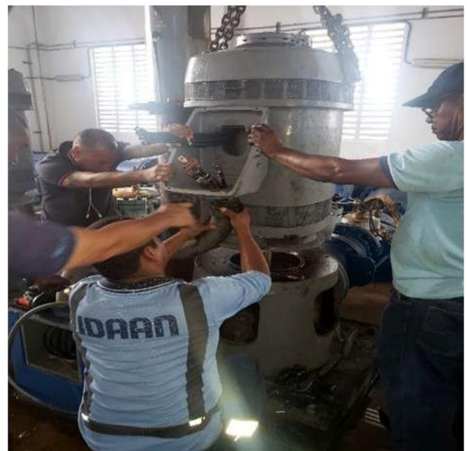
Proceso de Instalación de motor de 250HP en la Planta Centenario.
