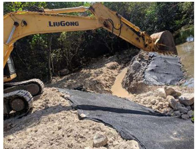
Excavación para zapata del dique.
