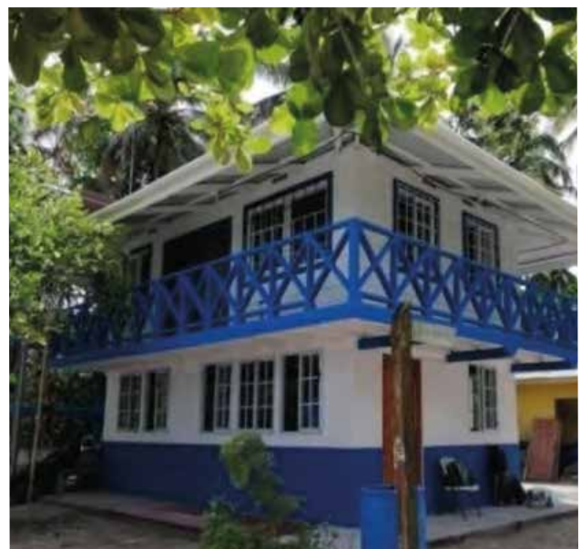
Habilitación de la casa de Guardaparques del PNM Isla Bastimentos, Bocas del Toro
