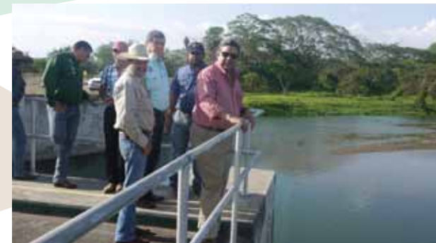
Visita del Señor Ministro Oscar Osorio Casal a las instalaciones del sistema de Riego Remigio Rojas
