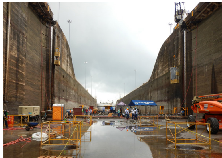
Reacondicionamiento de equipo sumergido en las esclusas panamax
