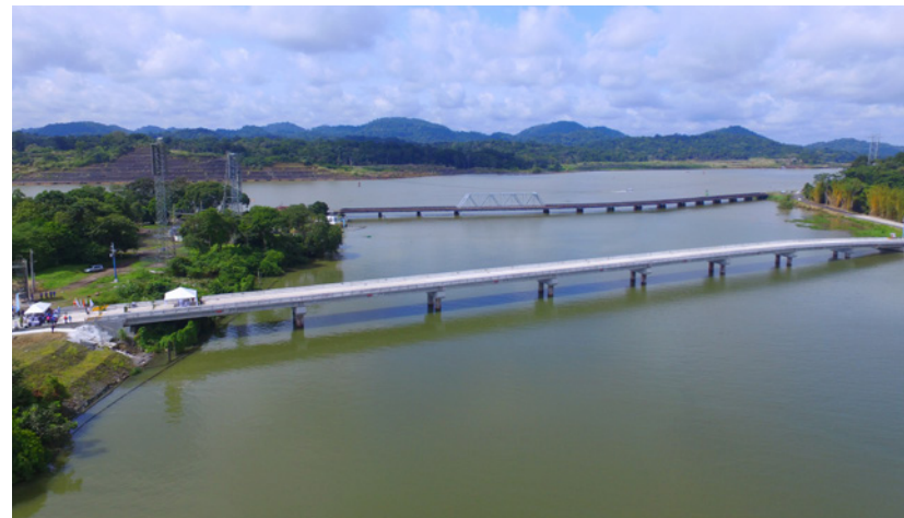
Nuevo puente de Gamboa sobre el río Chagres
