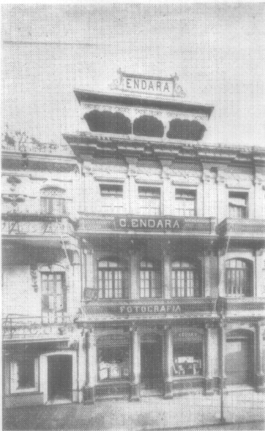
Edificio de la Fotografía de Carlos Endara. Comenzado en 1909 e inaugurado en 1910.
