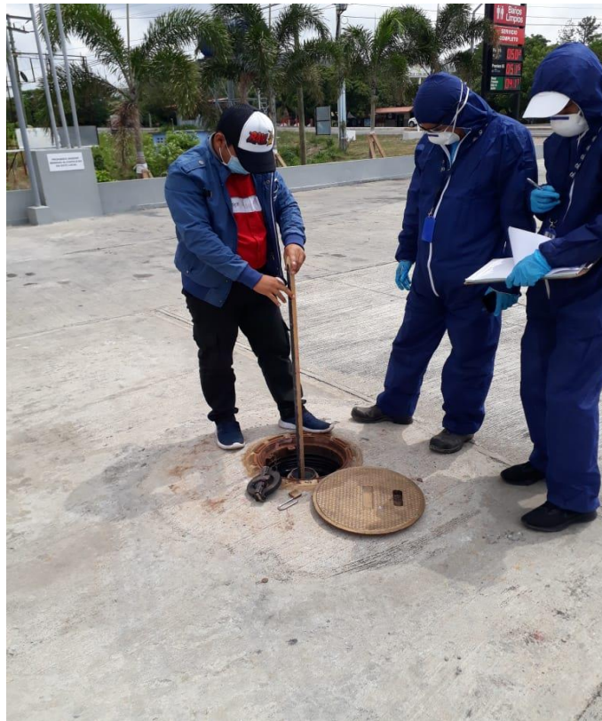
Verificación de agua en los tanques de reserva de combustible en surtidores y estaciones de la provincia
