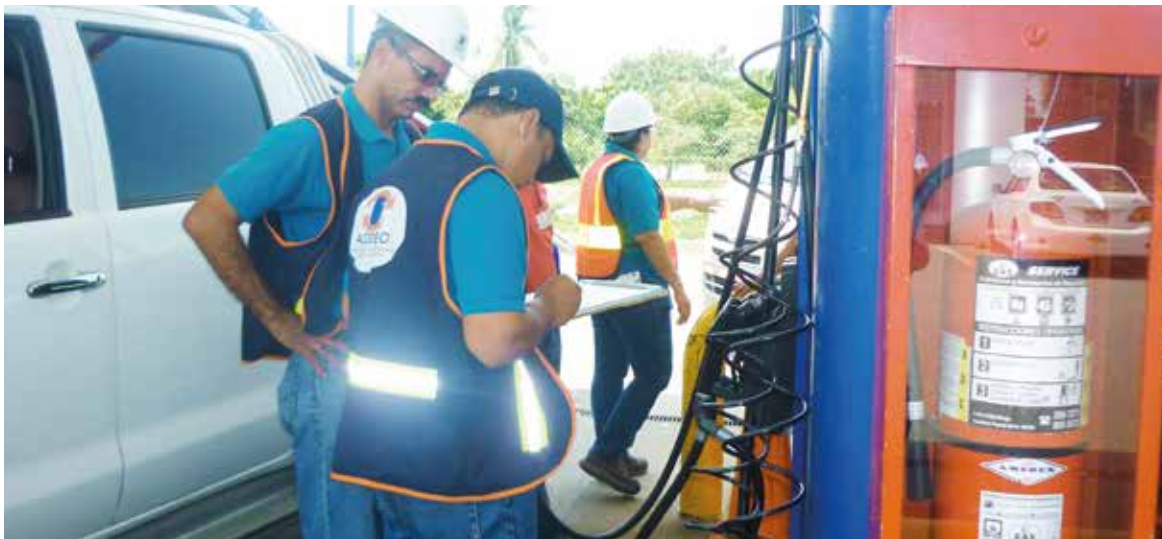
Operativo de combustible, revisando cantidad de agua en los tanques de almacenamiento
