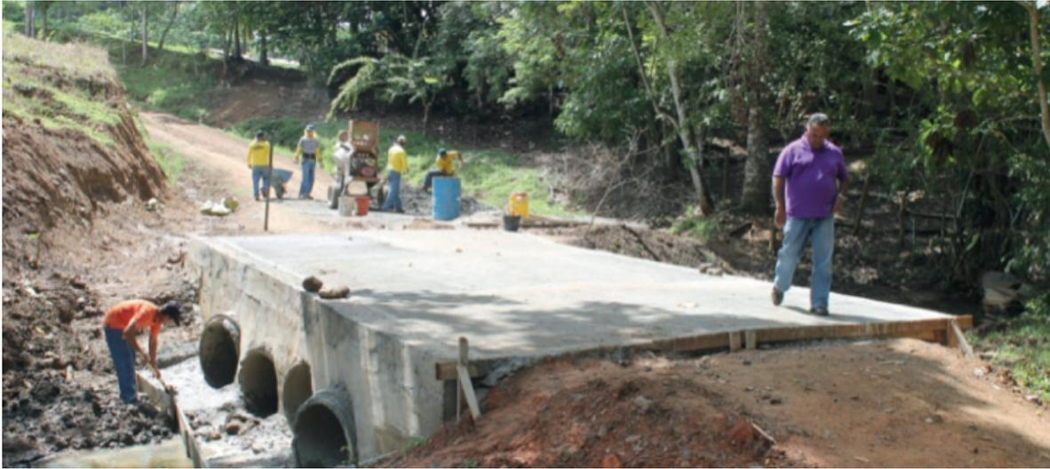
Tipo de proyecto: ampliación de cruce pluvial y construcción de losa de hormigón quebrada Lambo
