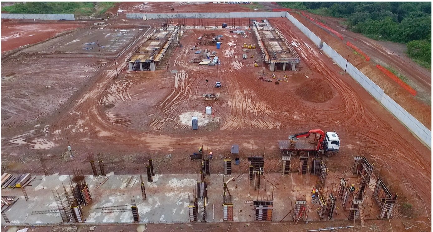
Imágenes aéreas de la construcción del nuevo Centro Femenino de Rehabilitación en Pacora, obra que se ejecuta con una inversión de B/.27,626,024.50.
