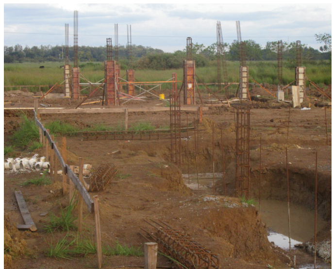
Avance de la construcción de la Fase 2 de la Academia de Formación Penitenciaria en Aguadulce, Coclé.
