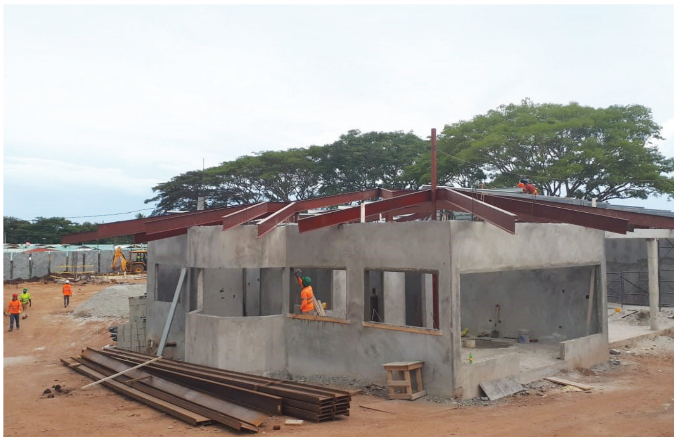
Construcción del Centro de Custodia y Cumplimiento de Herrera y que busca replicar el Modelo de Intervención Integral para Adolescentes en Conflictos con la Ley que se aplica en el Centro de Cumplimiento de Pacora.
