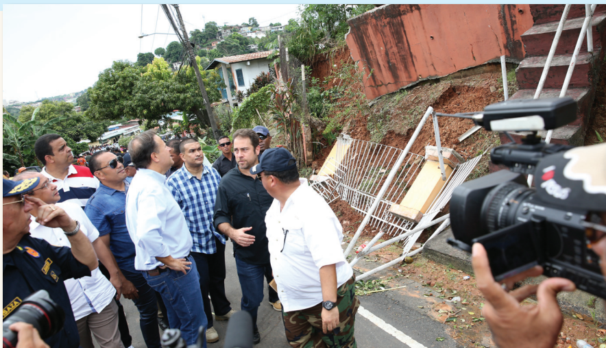
Presidente de la República, Juan Carlos Varela Rodríguez y miembros de su Gabinete evalúa daños causado por deslizamiento de tierra en Samaria.
