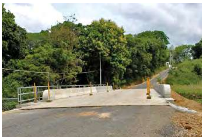
Rehabilitación de las Carreteras: Ocú - Las Minas y Valle Rico - El Potrero - Señales - Ocú.
