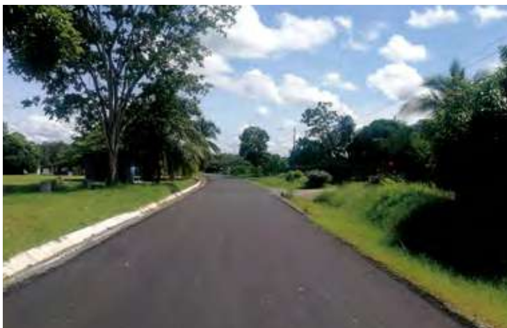
Construcción de carretera en Alanje.
