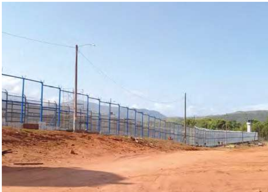
Rehabilitación de la cerca perimetral del Complejo La Joya.
