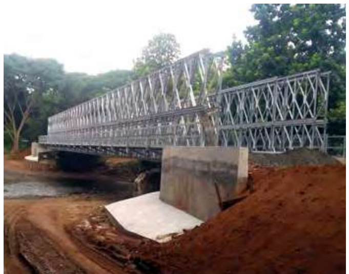
Construcción de puente en Las Guías de Calobre.
