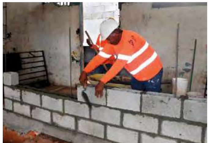
Trabajos de construcción en Centro Penitenciario de Chitre.
