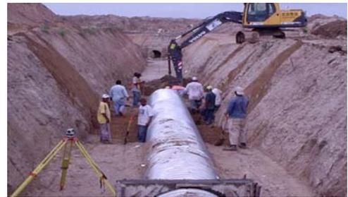
Tubería de aducción para transporte del agua de riego hacia los canales de principales en el sistema de Riego Lajas en el distrito de Penonomé.
