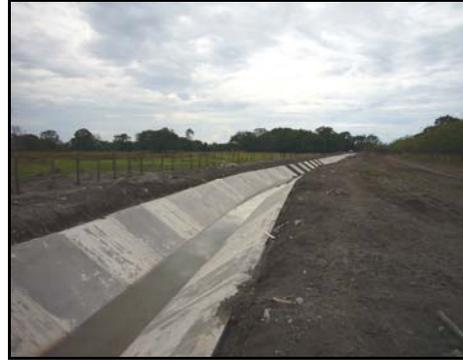
Izquierda: Obra de captación sobre el río Chico que permitirá la derivación de los caudales requeridos por el sistema. Derecha: Tramo de canal de conducción revestido para conducir un caudal de 5.00 m<sup>3</sup>/s a las áreas de riego.
