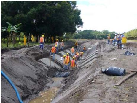
Proyecto Remigio Rojas: Revestimiento de hormigón reforzado canal de conducción (5.00 m<sup>3</sup>/s)
