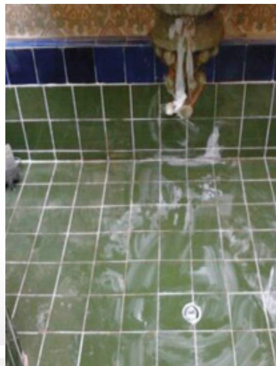
Reparación de la fuente patio andaluz
