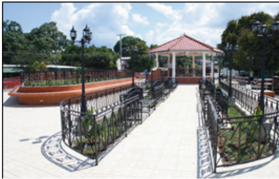
Fig.3 Construcción del Parque de Tonosí, Provincia de Los Santos
