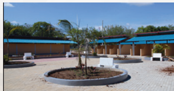
Fig. 8 Rehabilitación de las instalaciones de la Feria de Soná, provincia de Veraguas
