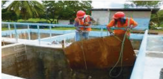
Trabajos de retiros de las placas en la Planta
