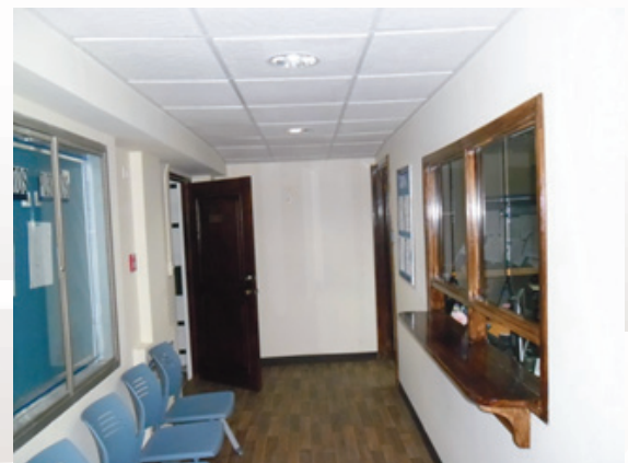
Remodelación de oficinas de compras
