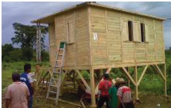
Construcción de viviendas a los afectados
