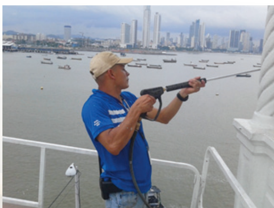
Limpieza y preparación de fachada para pintura
