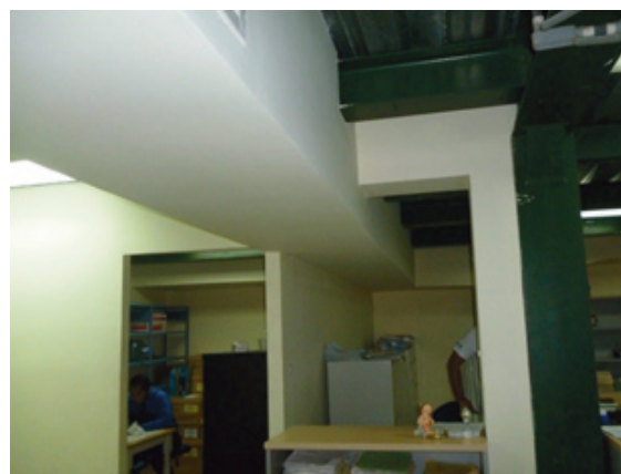
Remodelaciones y adecuaciones de aire en tesorería
