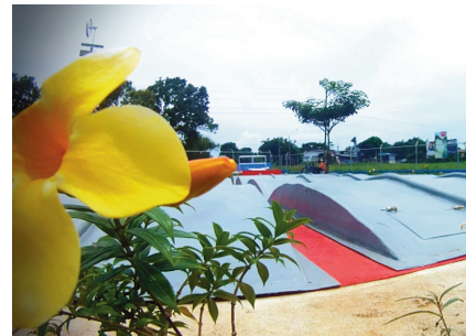
Planta de tratamiento de aguas residuales de Guararé
