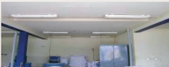
Reposición de lámparas en el edificio
