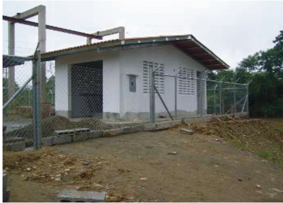
Imágenes antes de la Rehabilitación
