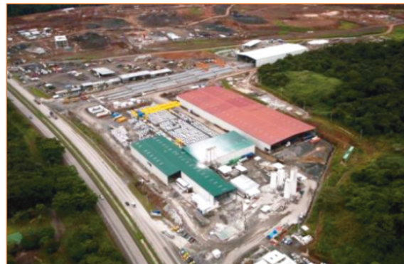
Planta de Prefabricados
