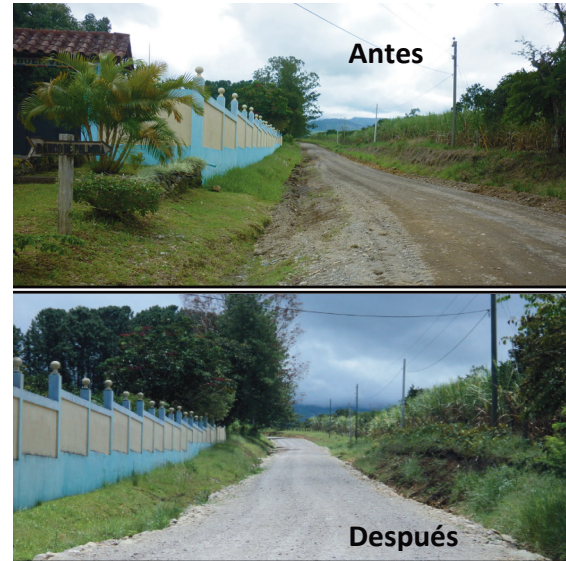
Fig.4. Rehabilitación de camino Divala – Palma Real – Palmira Banco. Provincia de Chiriquí
