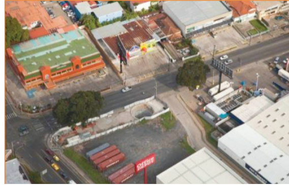
Pozo entre Vía Brasil y Vía España
