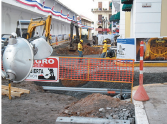
Supervisión de trabajos eléctricos y alcantarillado
