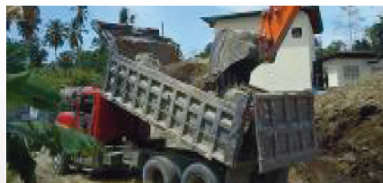
Trabajos para la rehabilitación de la Planta
