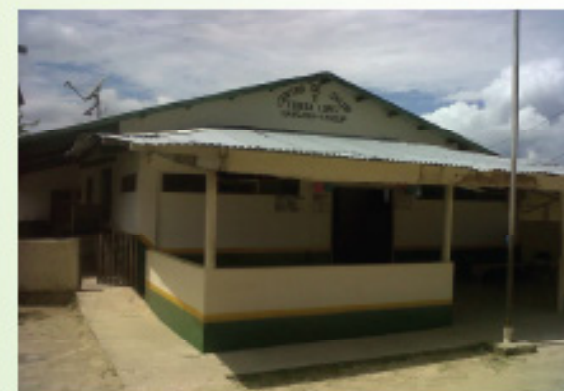
Reconstrucción del Centro de Salud de Ustupu
