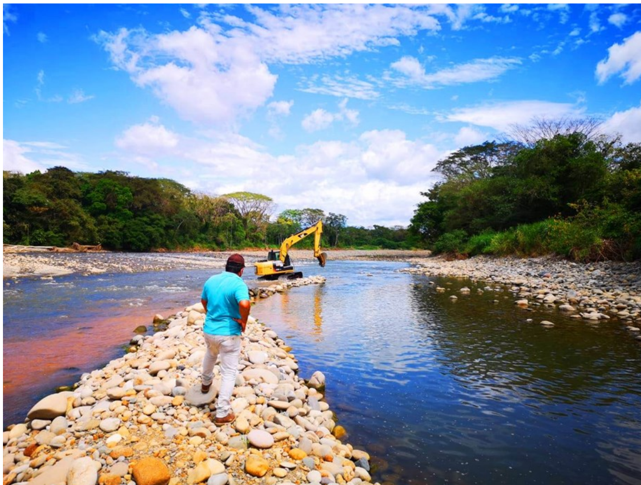
Trabajos de mejoras al muro de contención de la toma del río Chiriquí, David.
