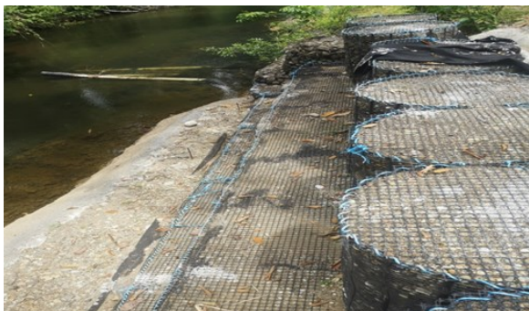
Muro de Gaviones para reforzamiento de Talúd. PTAP de El Real, Darién.
