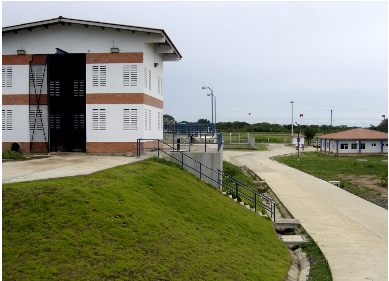
Planta Potabilizadora de Farallón.
