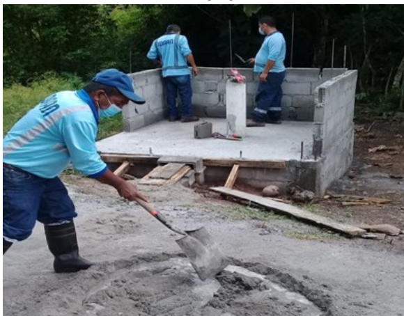
Construcción de caseta de Pozos.
