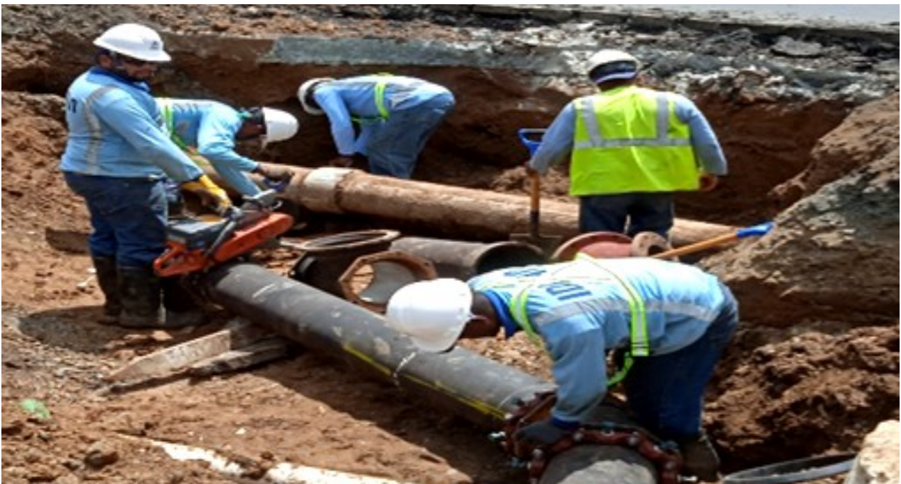
Interconexión de tubería de 24'' en Chilibre.
