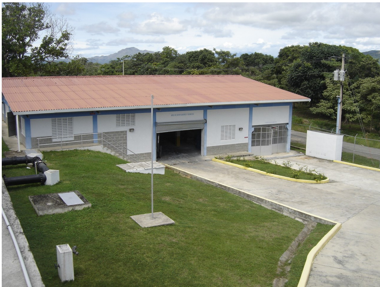
Planta Potabilizadora de Penonomé.
