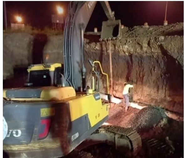
Reparación 6", vía Panamericana.
