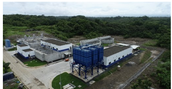
Nuevo Módulo de la Planta Potabilizadora Federico Guardia Conte.
