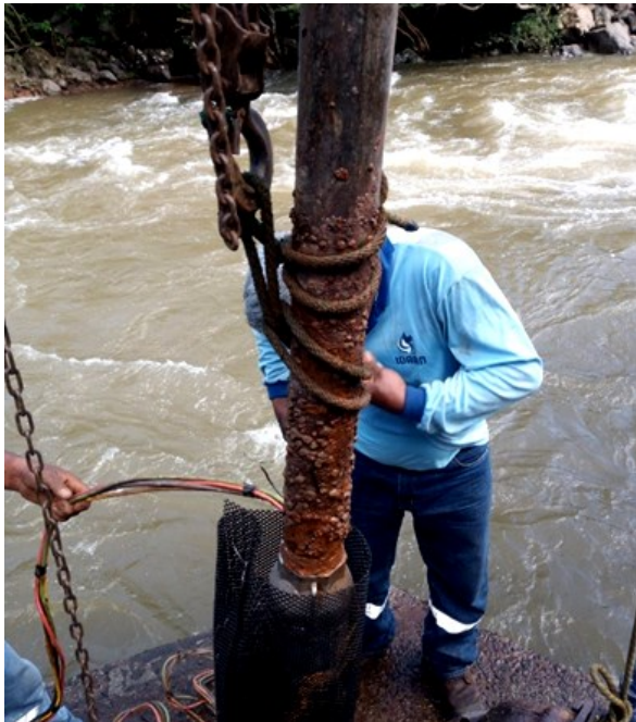
Mantenimiento a equipos de Bombeo.
