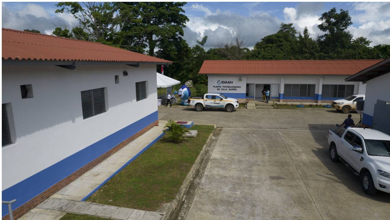
Pintura y colocación de logo en la nueva Potabilizadora de Villa Darién.
