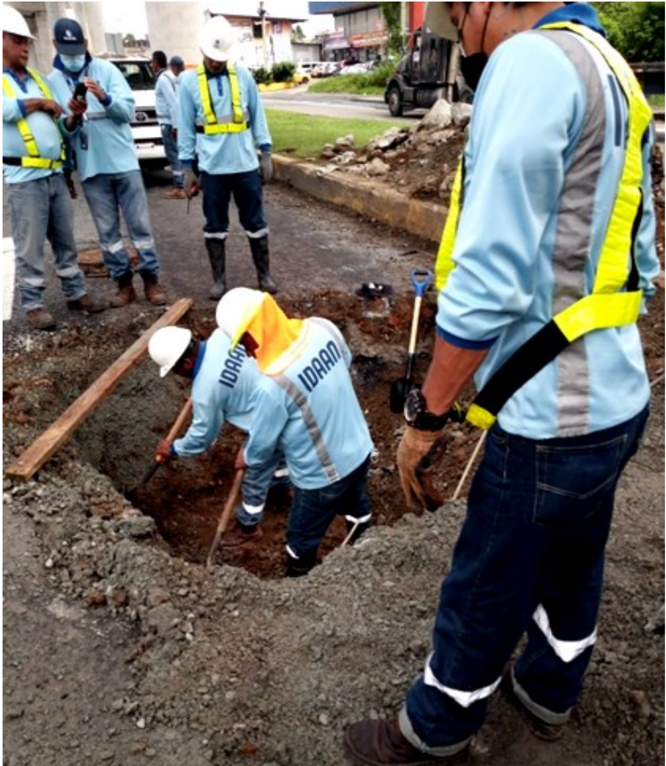
Interconexión en la Vía Panamericana 24x8.
