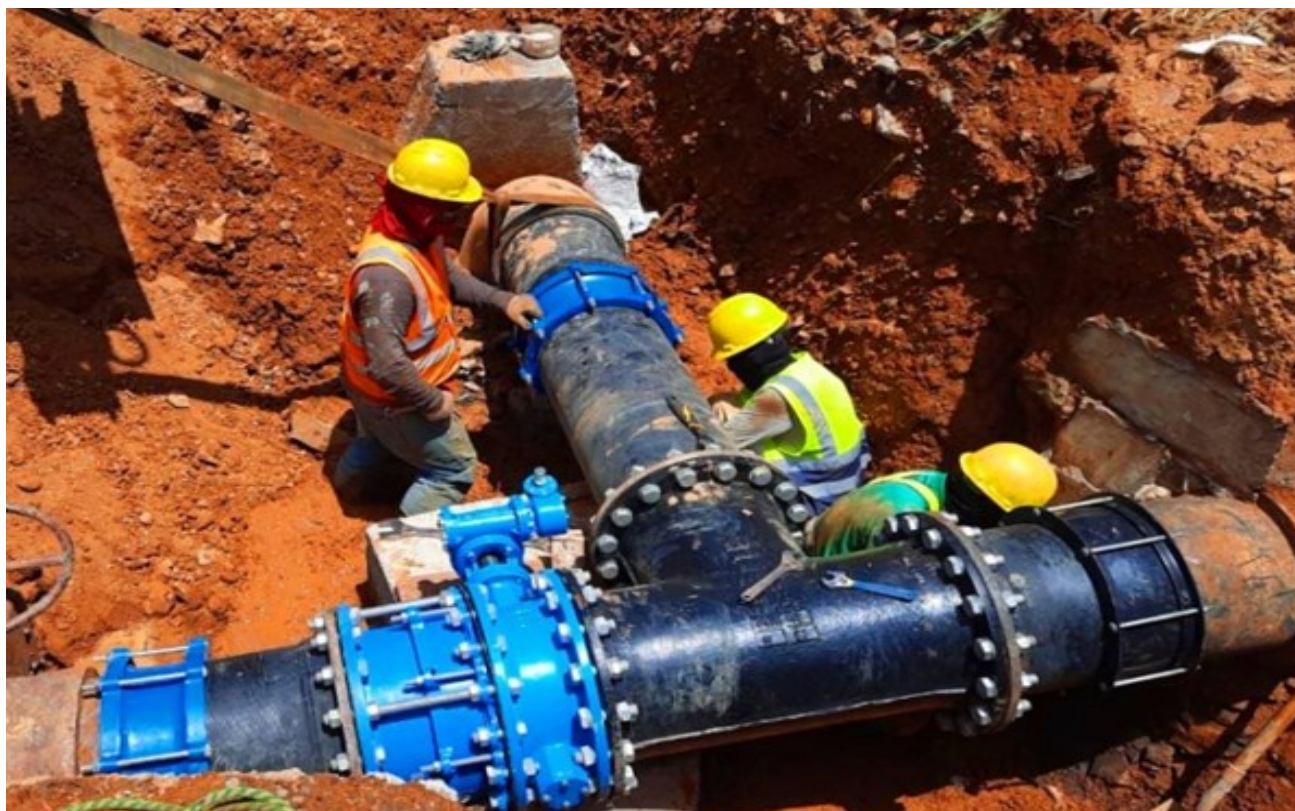
Trabajos de interconexión del proyecto David Fase 1.
