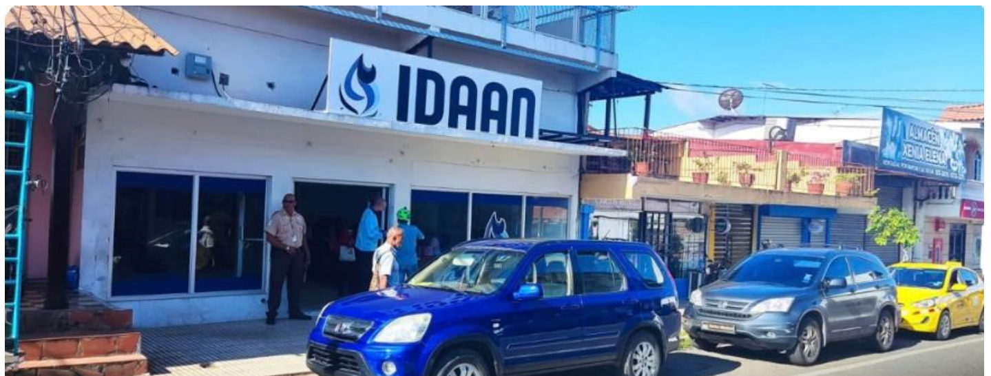
Ubicación de la Agencia Comercial de Las Tablas en sus nuevas instalaciones en la Avenida Belisario Porras.
