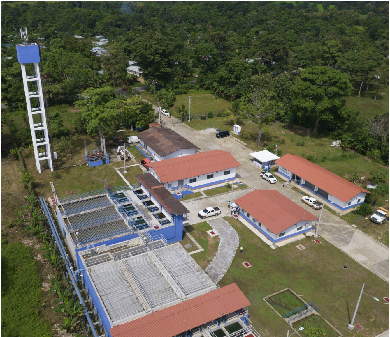
Planta Potabilizadora de Villa Darién.
