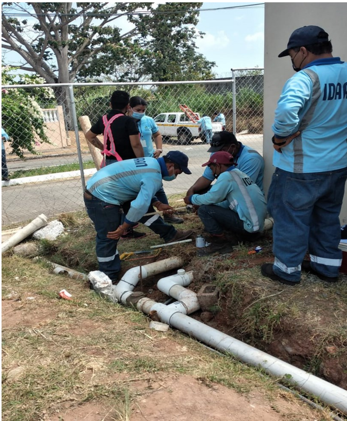
Interconexión de la estación de bombeo de la Barriada Residencial Don Juan a la línea de distribución existente.
