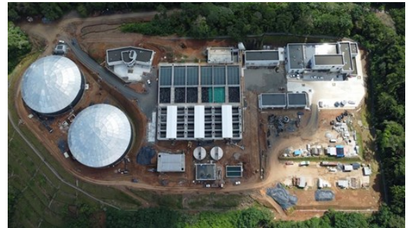
Avance del Proyecto PTAP Howard
