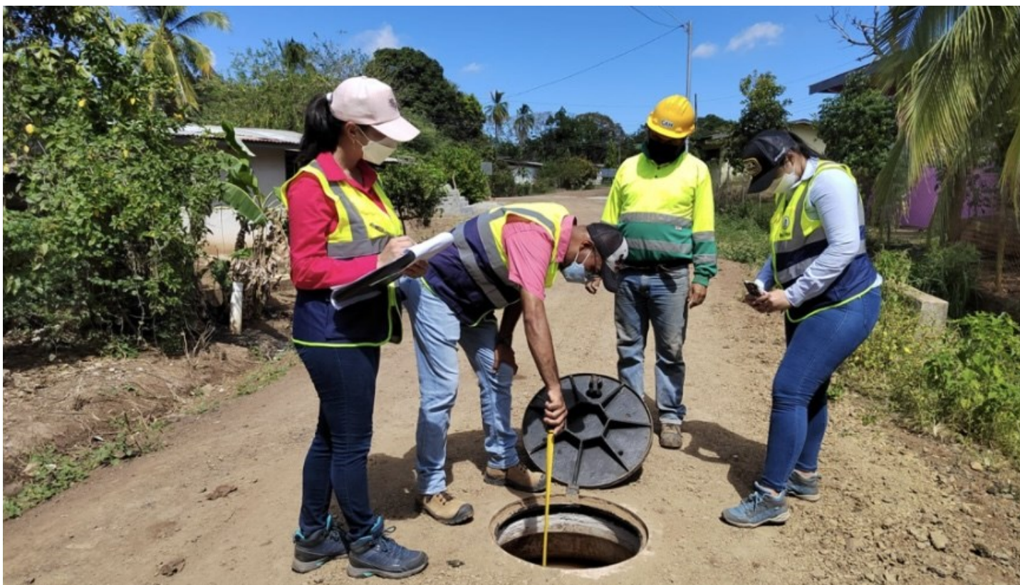
Pruebas de fuga y alineamiento en el proyecto de construcción del sistema de alcantarillado sanitario de Paritilla.
