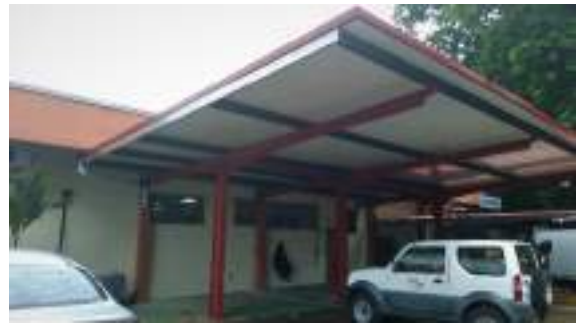
Construcción de alero para equipo pesado.
