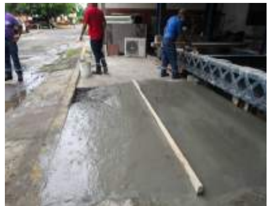
Reparación de losa del marco de pruebas.
