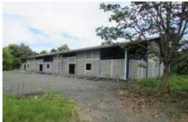
Edificio Taller, Centro Regional de Coclé.
