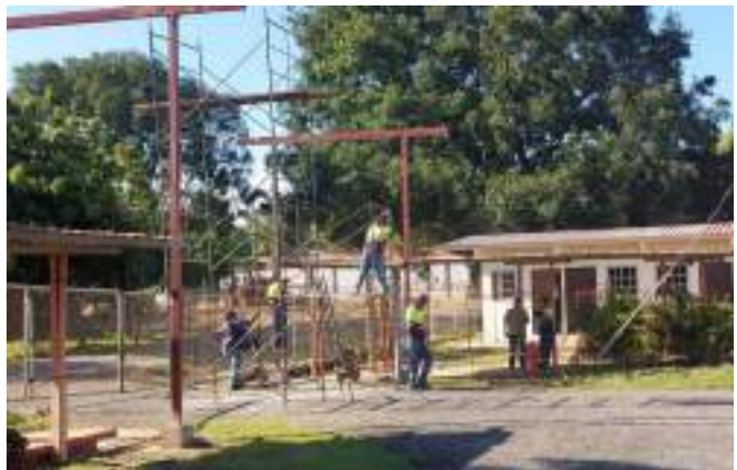
Construcción y acondicionamiento de Cobertizo en el Centro Regional de Azuero.
