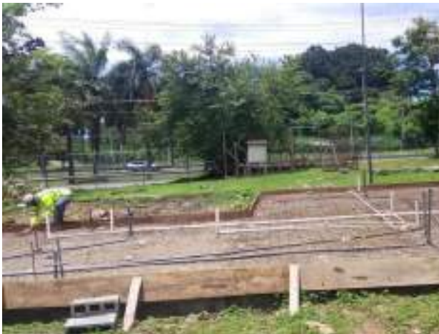
Construcción de plataforma para banco de pruebas del CINEMI.
