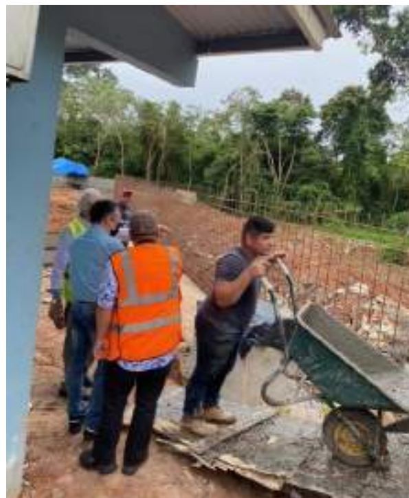
Inspección al muro perimetral de la Barriada El Bambú, Arraiján.
