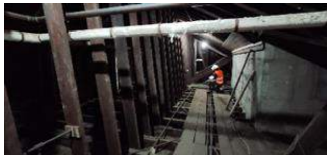
Evaluación estructural del techo del edificio 242 del Instituto Oncológico Nacional (ION).
