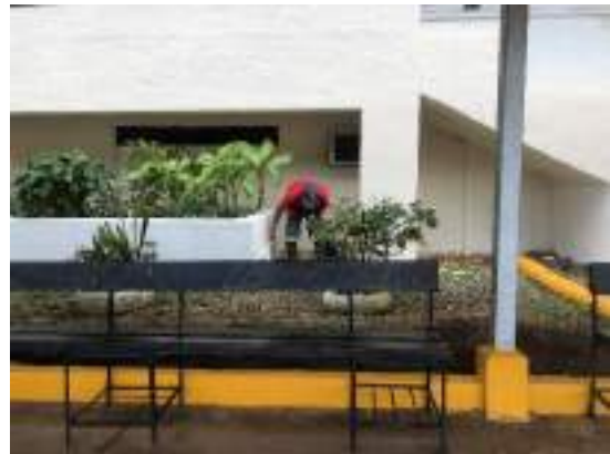
Mantenimiento a la infraestructura del Centro Regional de Colón.
