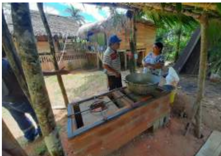
Construcción de estufa ecológica en la comunidad de Bonyik, ubicada en el corregimiento Teribe en la Comarca Naso Tjër Di.
