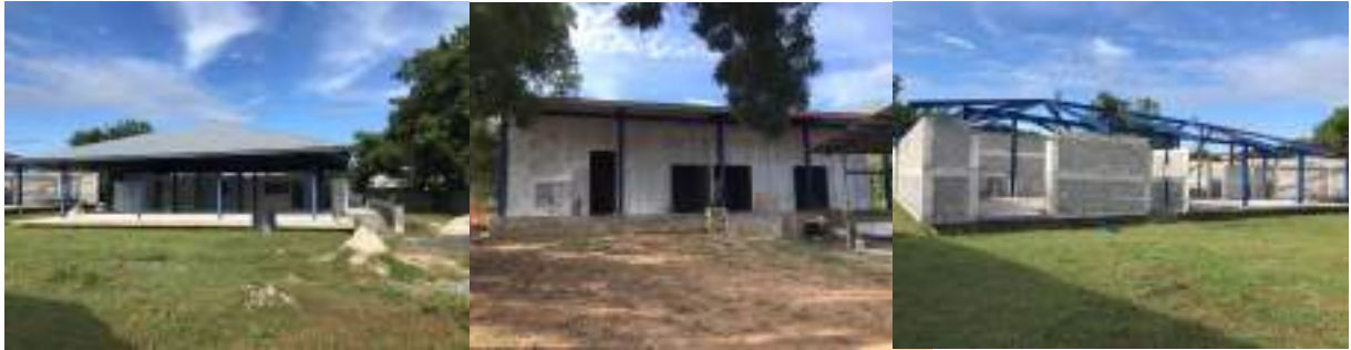
Edificio de Cafetería, Edificio taller y Facilidades Estudiantiles, Centro Regional de Azuero.
