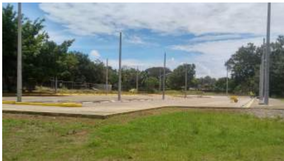
Estacionamientos en el Centro Regional de Chiriquí.
