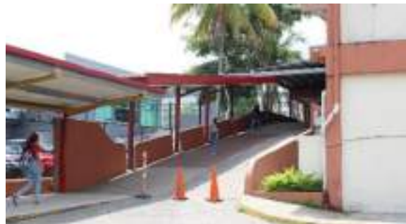
Extensión de cobertizo en el Edificio Administrativo.
