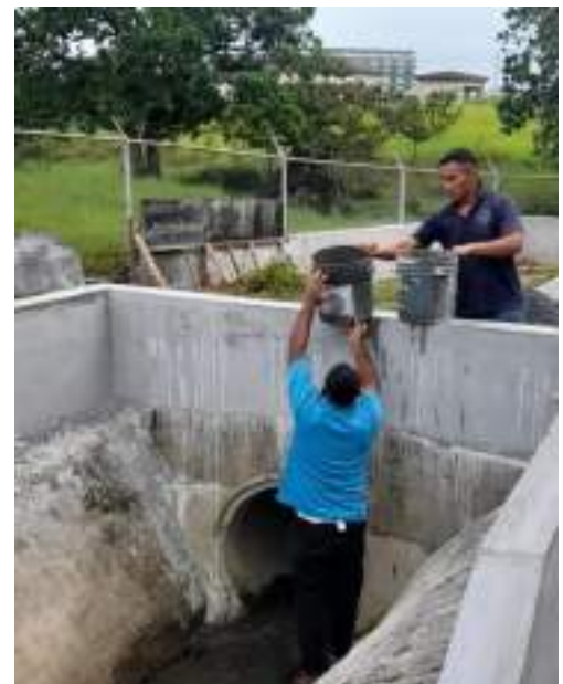
Construcción de cabezal y alcantarillado para desvío del agua en el lago del Centro.
