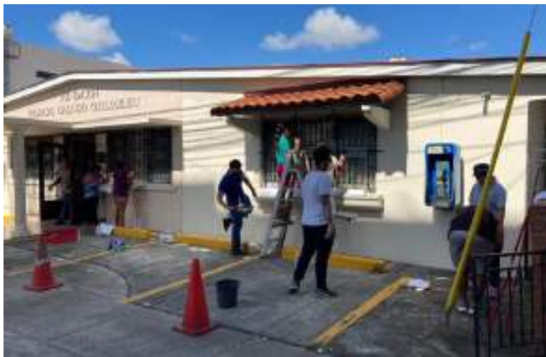
Jornada de mantenimiento de las instalaciones del Patronato Luz del Ciego.
