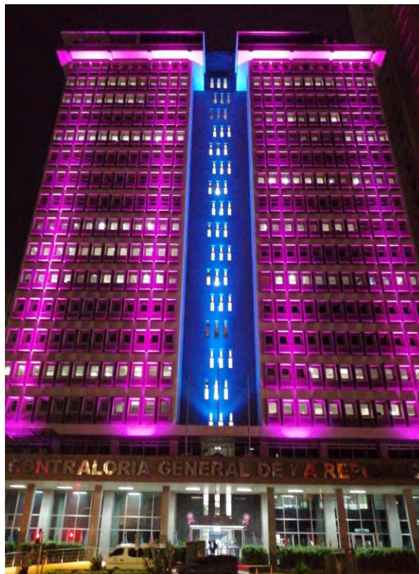
Programación de escenas del sistema de iluminación de la fachada el edificio sede, elaborado por la empresa Centrolum Panamá, S.A. Octubre de 2022.
