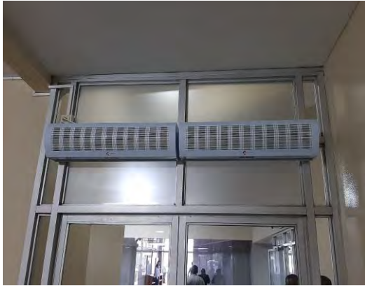
Instalación de cortinas de aire en la Planta Baja del edificio sede y pasillo del Edificio Gusromares, instalación realizada por personal del Departamento de Mantenimiento. Julio de 2022.
