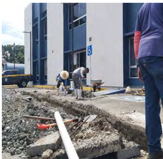
Reparación del tanque séptico de Bocas del Toro
