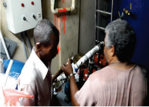
Instalación de bombas de agua para el Palacio de las Garzas.
