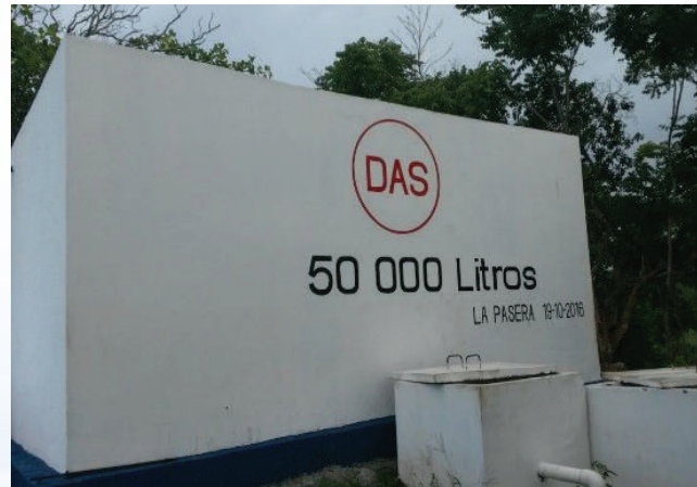
Fig. 2. Proyecto 60825 - Mejoras al acueducto de La Pasera.
