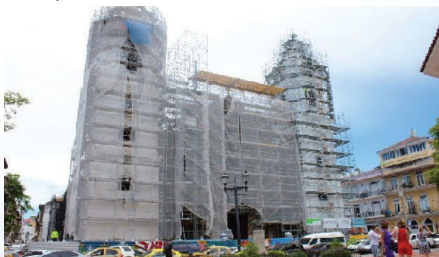
Fachada de la Catedral en proceso de intervención.
