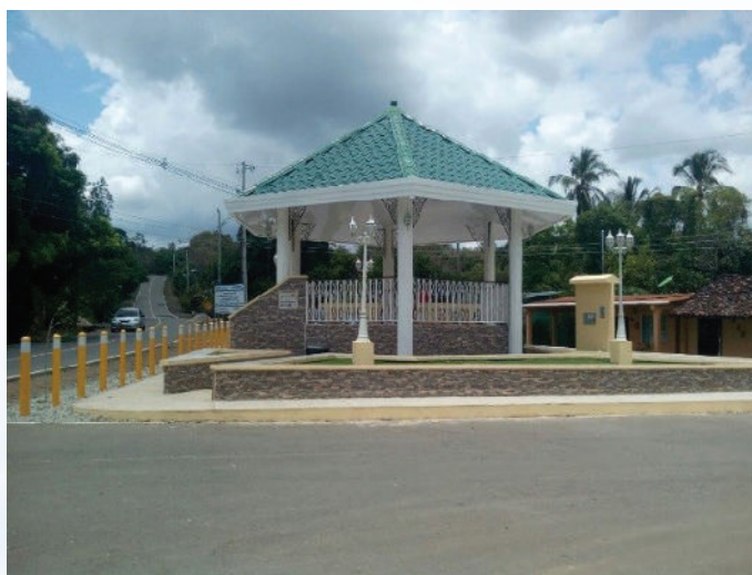
Fig. 6 Proyecto 60784 “Construcción de parque en la comunidad de El Muñoz”, Los Santos
