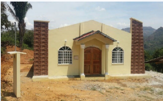
Fig. 1. Proyecto 60935. Construcción de Capilla de Calabazo #1.
