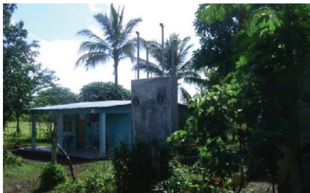
Tapia instalada - Comunidad Las Cabras Adentro en Pesé.
