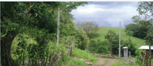
Línea de distribución eléctrica y tapias instaladas Comunidad de Llanos del Río
