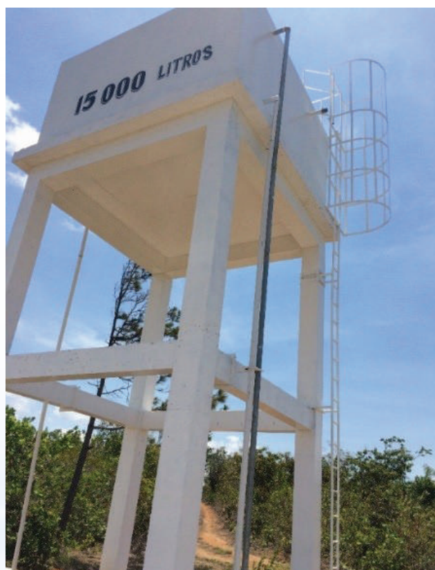
Fig. 3 Proyecto 60750 “Construcción de acueducto rural en el sector Las Peñitas de Chumical”
