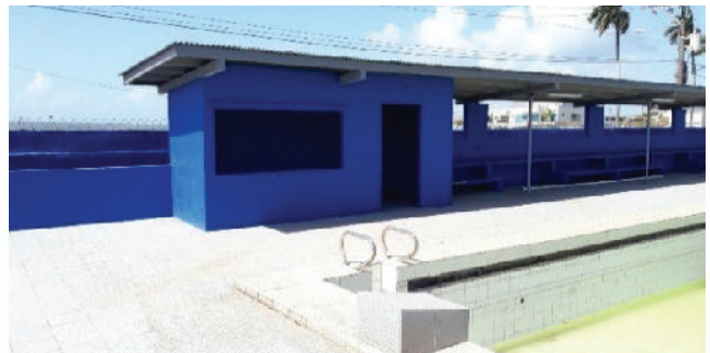
Fig.5 Proyecto 60649 “Rehabilitación del complejo deportivo de Colón”
