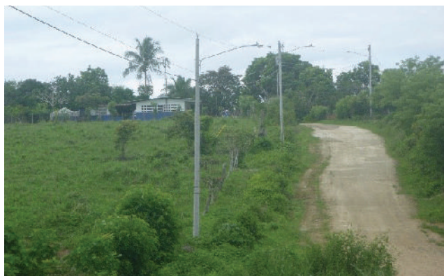
Línea de distribución eléctrica - Comunidad de Tres Quebradas.
