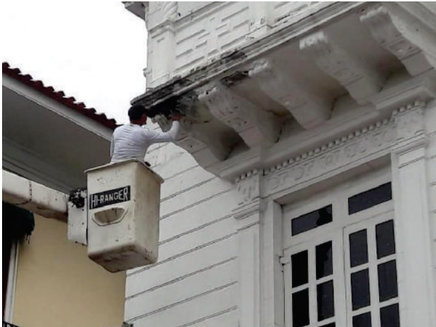
Reparación de canes de aleros de Palacio.
