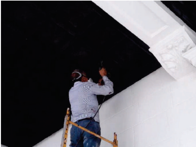
Trabajos de laqueo de cielo rasos de la entrada de Palacio.
