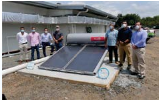
Donación de Sistema Termosolar a Hospital Integrado Modular
