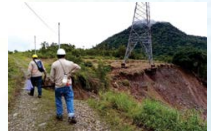
Restauración de torres de transmisión.
