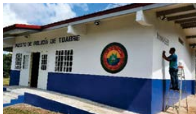
Proyecto: 61086 Construcción de estación de la policía en Tambo, provincia de Coclé Inversión: 94,356.16
