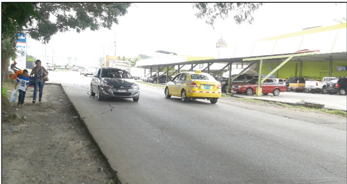
Ensanche a cuatro carriles, vía a Puerto Vacamonte (desde puente sobre la Autopista Arraiján- La Chorrera).
