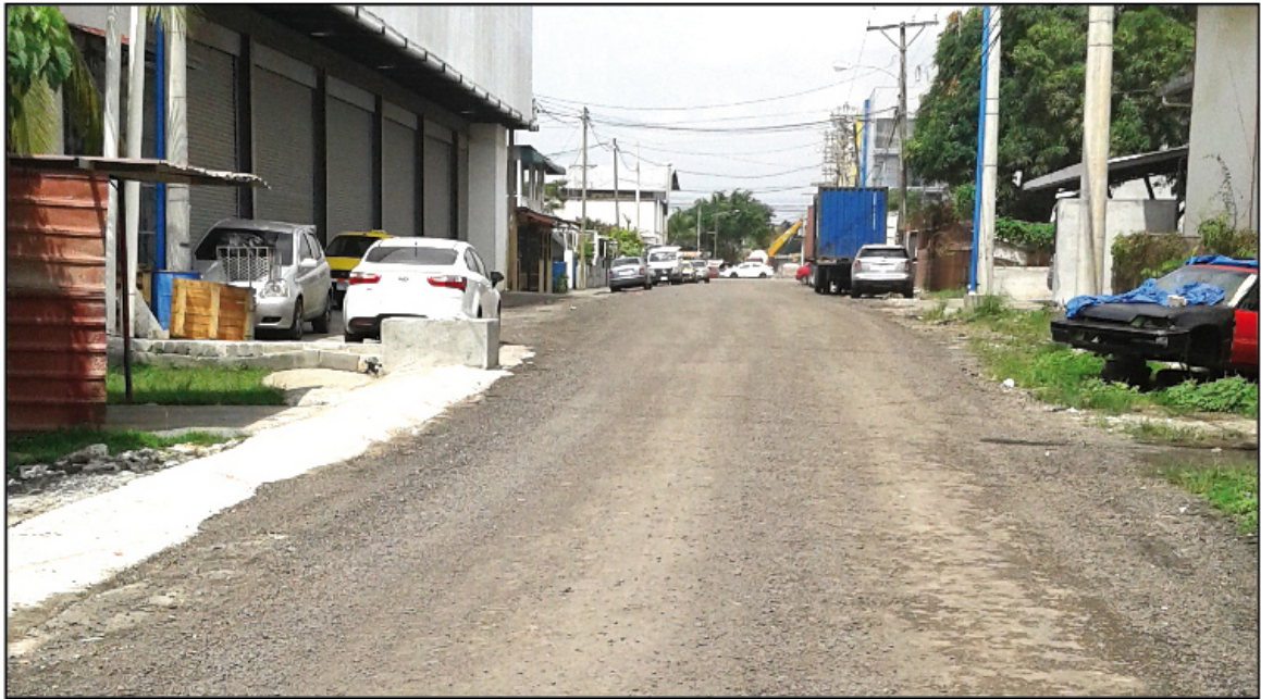
Construcción calle Las Mareas y calle 3ra Llano Bonito, Juan Díaz, Panamá.
