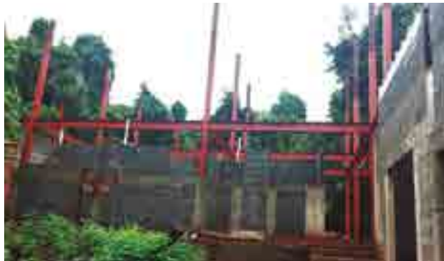
Avances en la obra de construcción
