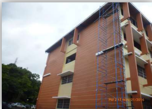
Adición de Aulas en el Edificios N° 1
