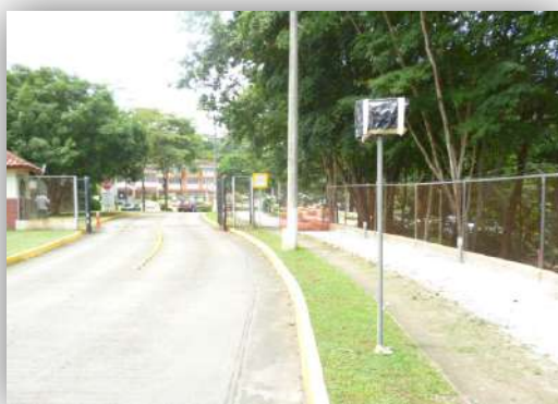
Ampliación de Aceras en el Campus Víctor Levi Sasso (Fase II)
