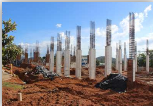
Construcción del Edificio de Aulas (I Fase) del Centro Regional de Panamá Oeste
