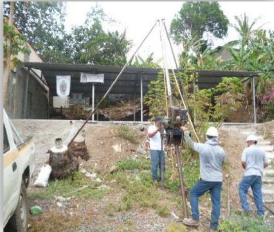
Perforaciones de suelo en la Capilla Altos de La Torre, Panamá
