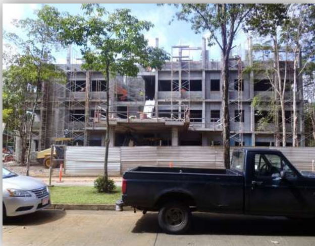
Construcción del Complejo de Investigación, Edificio de los Centros de Investigación-VIPE
