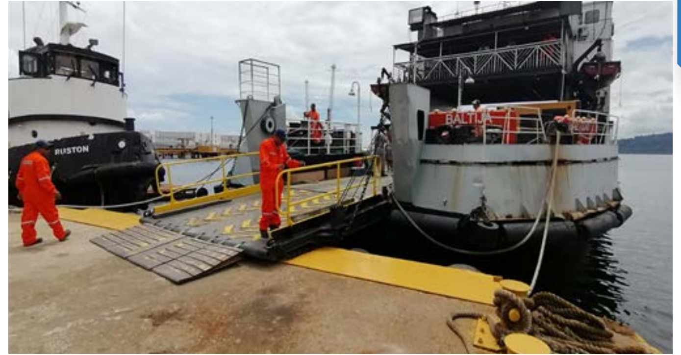
Mantenimiento y mejoras al Muelle Fiscal de Almirante, distrito de Almirante, provincia de Bocas del Toro
