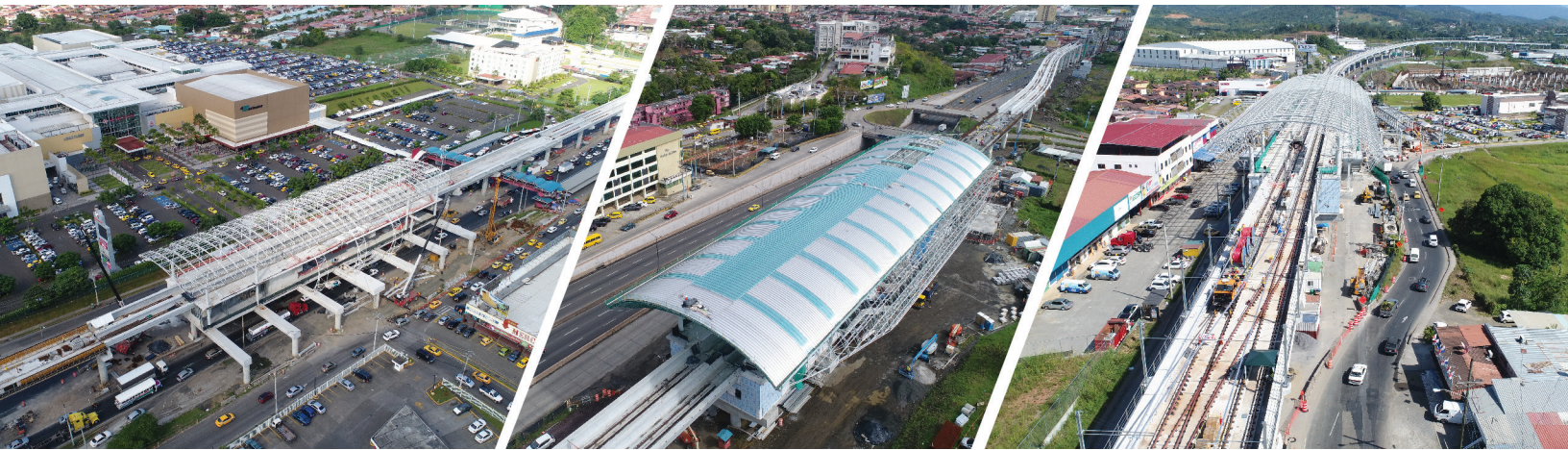
Estación Cerro Viento
