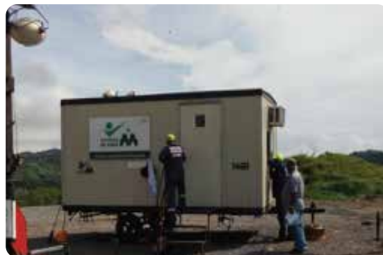
Acondicionamiento de oficina tipo contenedor
