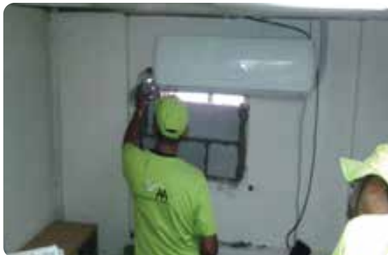
Trabajos de albañilería
