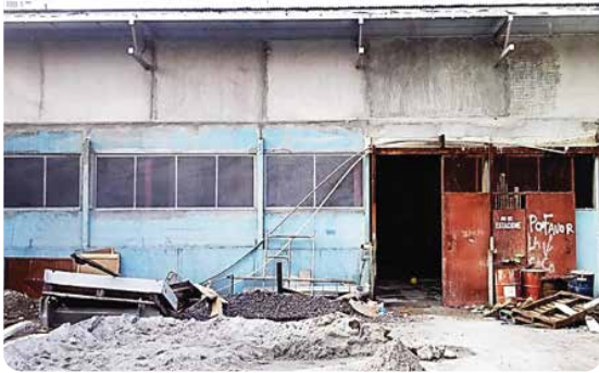
Remodelación del depósito
