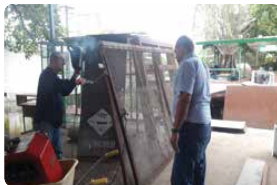
Instalación de puertas
