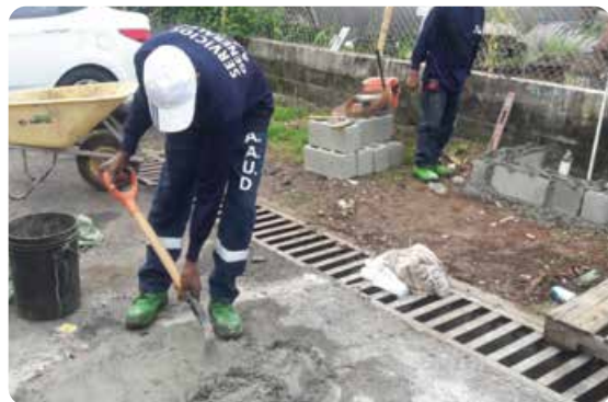
Trabajos de construcción
