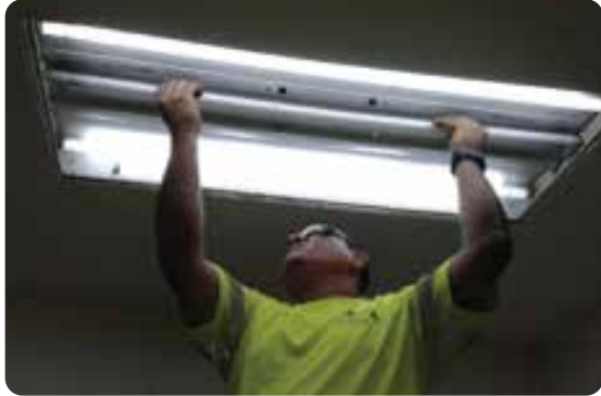
Reparación de luminarias en oficinas y pasillos
