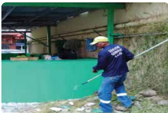
Pintura en lavadero PH Multiplaza
