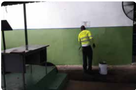
Pintura en estructuras
