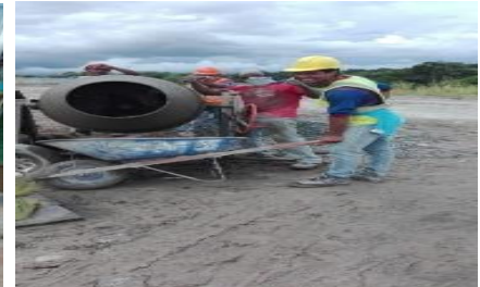
Práctica en el “Proyecto de Construcción de Barriada en Miraflores, Penonomé”.
