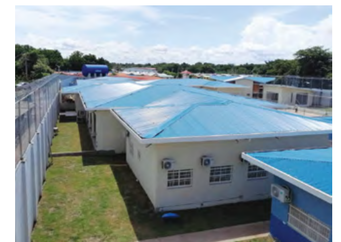
Estudio, diseño, construcción y equipamiento del Centro de Cumplimiento de Herrera, con un avance actual de 75%.
