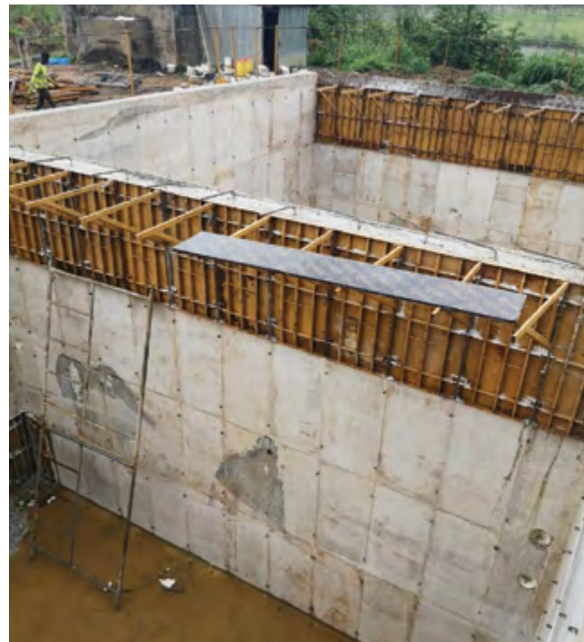
Construcción de la Planta de Tratamiento para los Centros de Custodia, Cumplimiento y Transición para Adolescentes en Las Garzas, en ejecución 64%.
