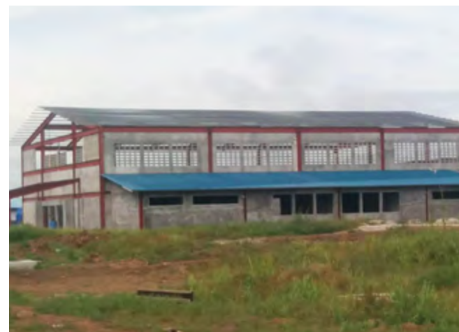
Edificios en construcción en la Academia de Formación Penitenciaria, Segunda Fase. Ejecución actual 75%.
