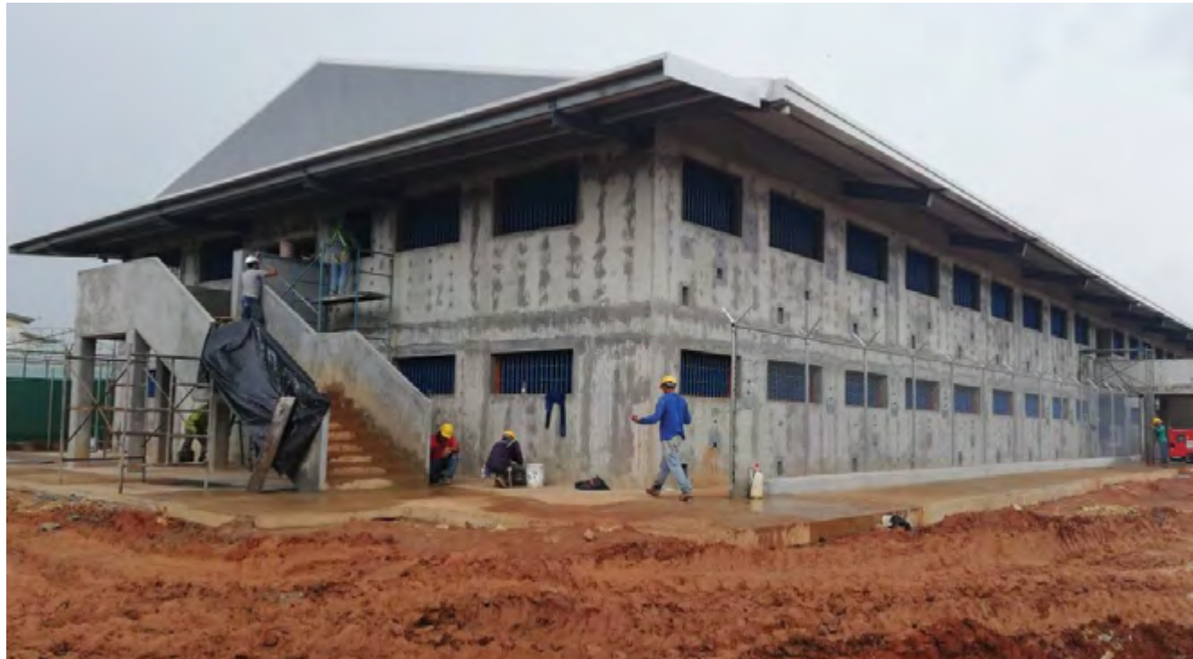
Construcción del Pabellón N.º 6 del Centro Penitenciario La Joya.
