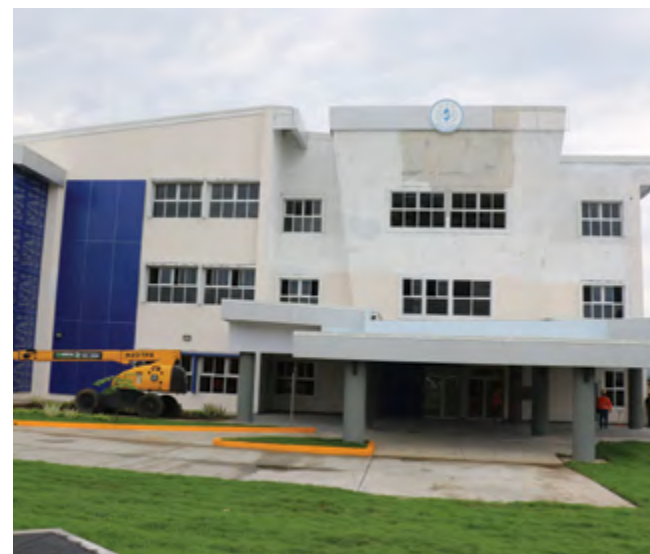
Se culminó la primera fase del nuevo hospital Dionisio Arrocha en Puerto Armuelles.
