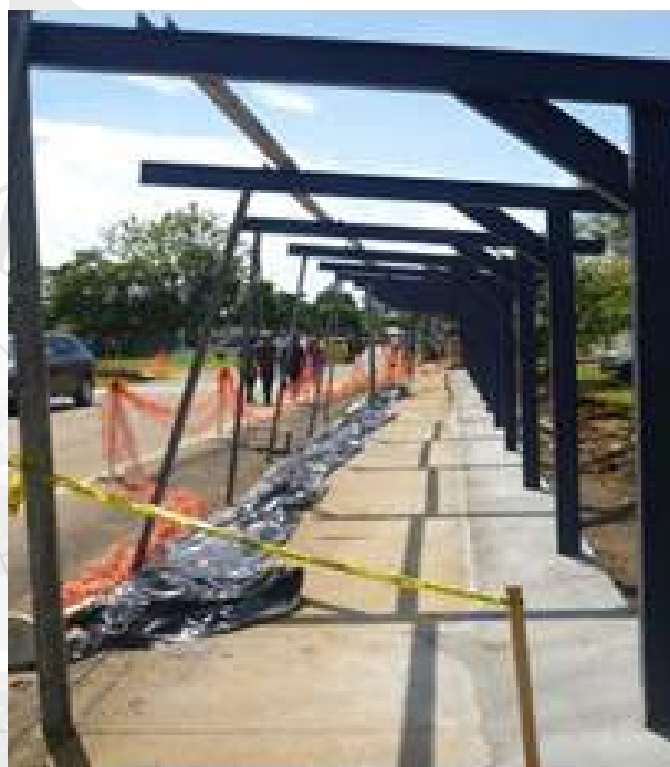
•Segunda etapa del cambio de imagen, cobertizo completo, desde la calle interamericana hasta la parada de buses y toda la parte interna y portones de acceso a la universidad con un avance de 20%.
