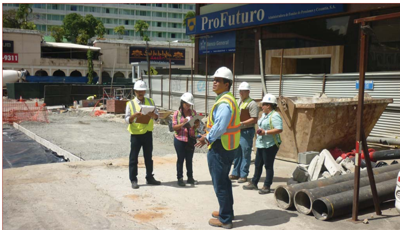
Inspección a la línea 1 del Metro.
