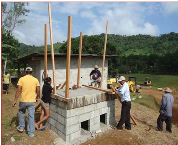
Construcción de letrina abonera en Panamá Oeste.
