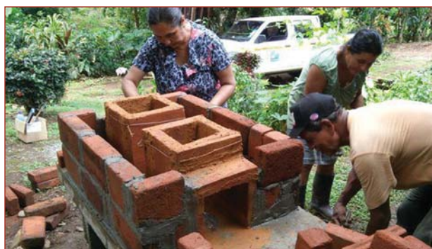
Construcción de estufa ecológica en la comunidad de Cimarrón, Bugaba, Chiriquí.
