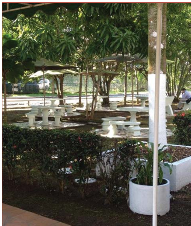
Pintado de bancas y masetas exteriores de la sede central.
