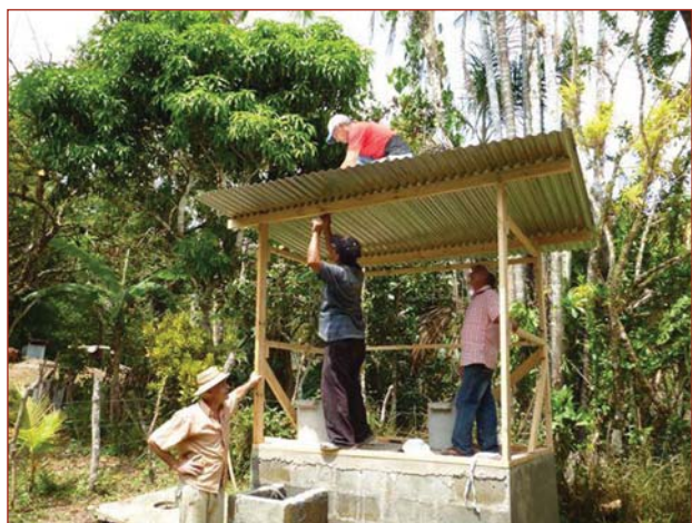
Construcción de una letrina abonera de techo.
