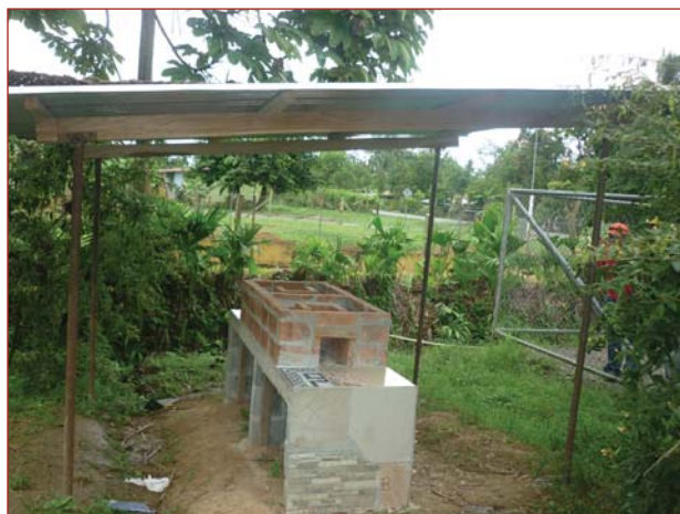
Construcción de estufas ecológicas en Bocas del Toro.
