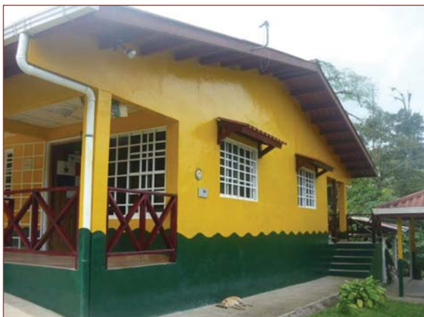
Mantenimiento de las instalaciones de la sede del Parque Nacional Santa Fe, Veraguas.
