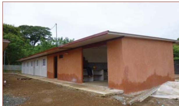
Inspección a proyecto de construcción, para determinar si cuenta con EIA aprobado.
