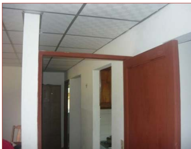
Mantenimiento en la sede del Parque Nacional Camino de Cruces.
