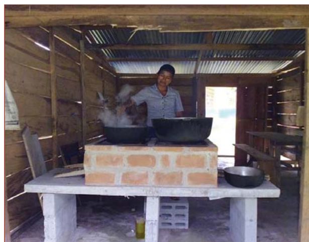
Construcción de ecoestufa en Panamá Oeste.
