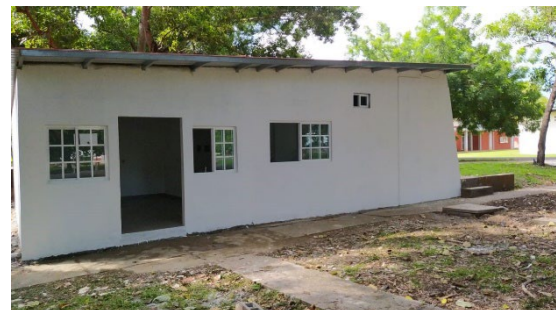
Construcción y adecuación de instalaciones para el Laboratorio de Plaguicidas.
