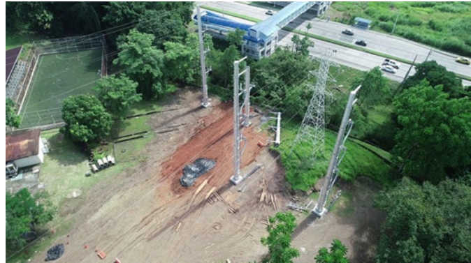
Trabajos de reubicación física de las líneas de transmisión.
