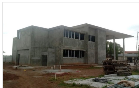
Edificio Núcleo de Servicios Especializados, Centro Regional de Veraguas.
