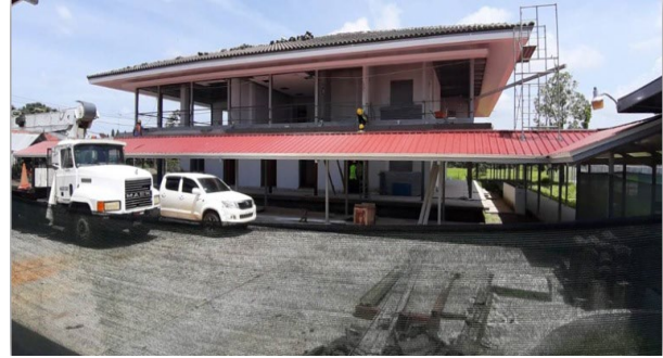
Edificio de Aulas, Estacionamiento y Cobertizo.
