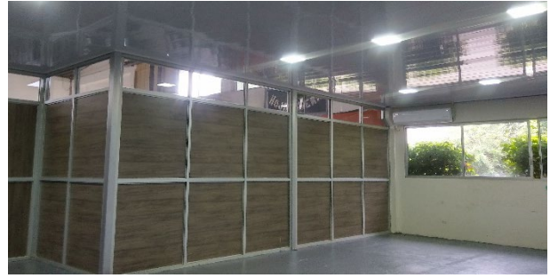
Adecuación de área para el Laboratorio de Fabricación Digital Fab Lab, Centro Regional de Chiriquí.
