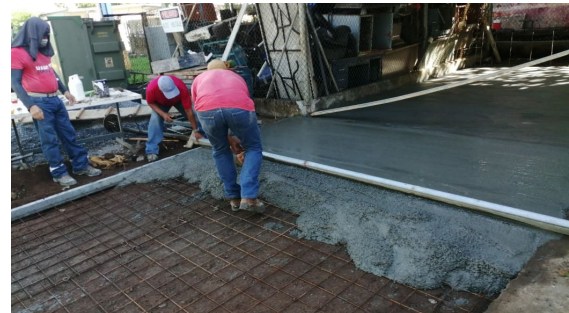
Adecuación de área para Taller de Soldadura, Centro Regional de Chiriquí.
