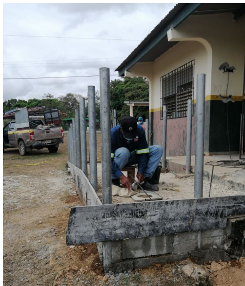
Ensayo de densidad de campo para el mejoramiento del subcentro de salud del Hato de San Juan de Dios, Aguadulce, Coclé.
