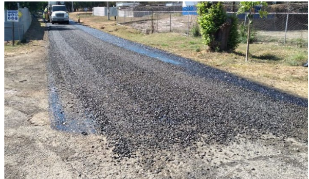
A través del convenio de cooperación entre UTP y el Ministerio de Obras Públicas, se realizaron trabajos de mejoras a las calles internas del Centro Regional de Azuero.
