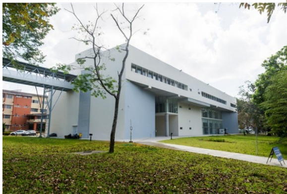
Edificio de Facilidades Estudiantiles y puente de acceso que conecta con el Edificio No.1.
