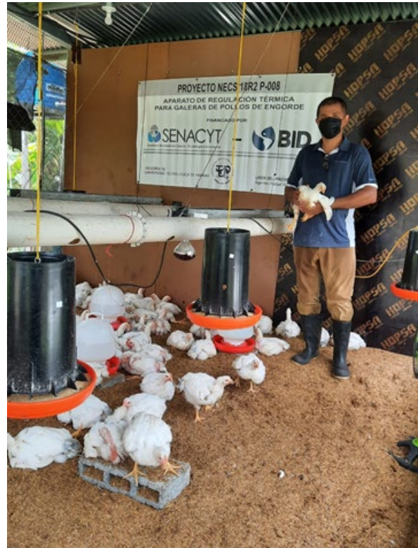
Proyecto: “Aparato de Regulación Térmica para Galeras de Pollos de Engorde” por medio de la circulación de un líquido en tuberías, bajo el suelo.
