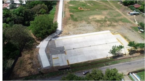
Construcción de Estacionamiento y Acera, Centro Regional de Chiriquí.
