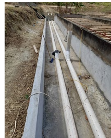
Reparación y ampliación de la tina del tanque séptico.
