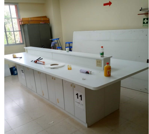
Confección e instalación de sobres de mesa para laboratorios del Edificio No.3.
