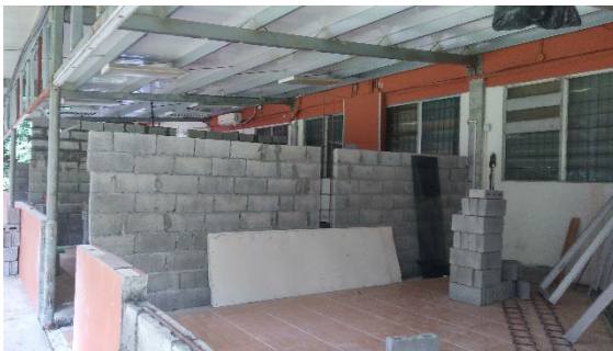
Cerramiento interno para nuevas aulas de clases, Centro Regional de Chiriquí.
