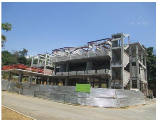
Edificio de la Dirección General de Tecnología de la Información y Comunicaciones (DITIC)
