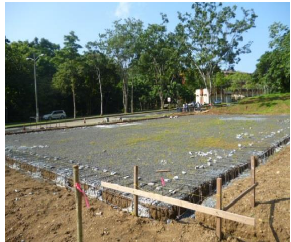
Construcción de las Canchas Deportivas de Baloncesto, Tenis, Frontón
