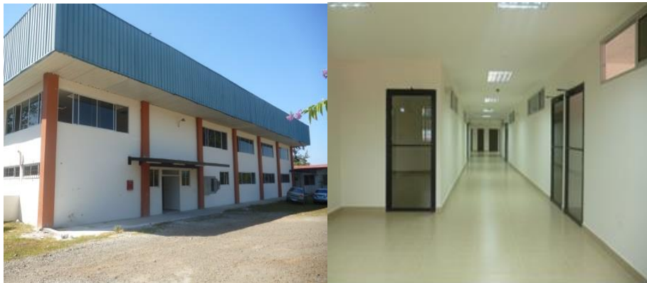
Remodelación del Edificio Taller de la Facultad de Ingeniería Eléctrica, Centro Regional de Chiriquí
