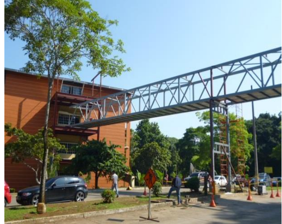
Construcción del Paso Elevado Peatonal del Edificio N° 1 al N° 3
