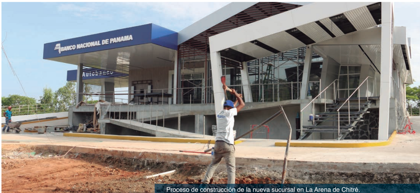
Proceso de construcción de la nueva sucursal en La Arena de Chitré.
