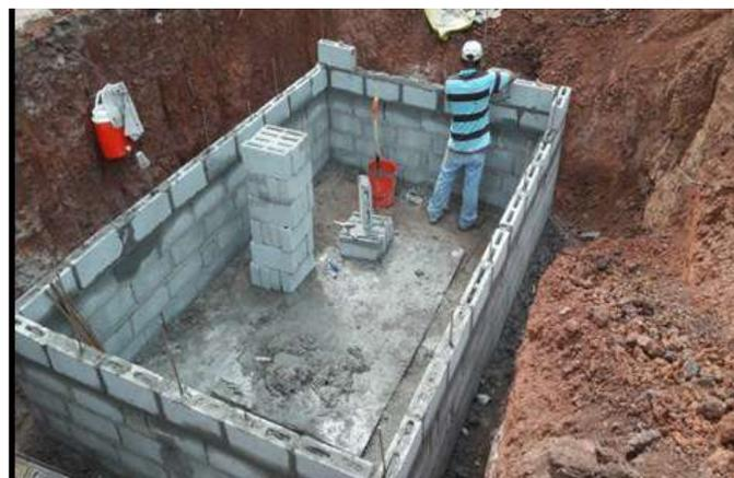
**Mejoras a la red potable de Parita, tanque de almacenamiento de 50,000 galones, y construcción de caja de válvula.**
