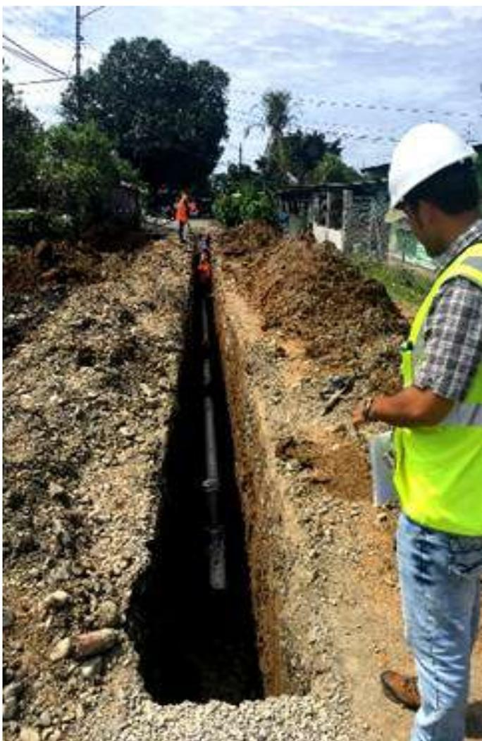
**“Construcción del Alcantarillado de Changuinola” fin instalación de tubería sanitaria. septiembre 2017.**
