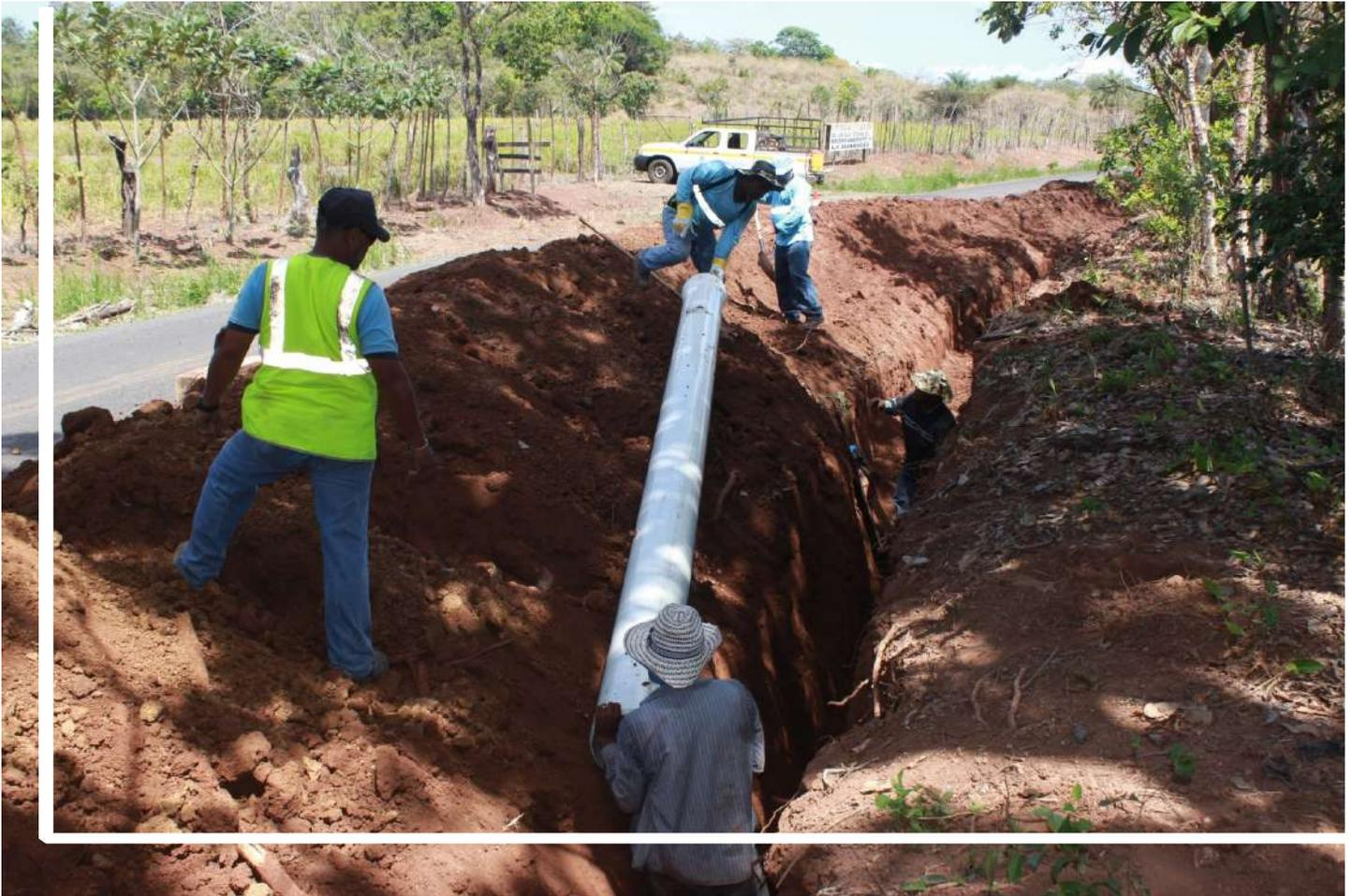
**Instalación de línea de conducción de 10 pulgadas de Santiago hacia Atalaya.**
