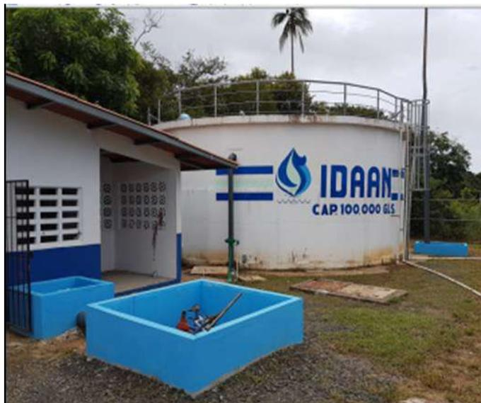
Tanque de reserva de 100,000 galones, como depósito de las aguas de fuentes subterráneas, bombeadas posteriormente a un tanque elevado de 50,000 galones, con 20 metros de altura, para abastecer comunidades en Pedasí.
