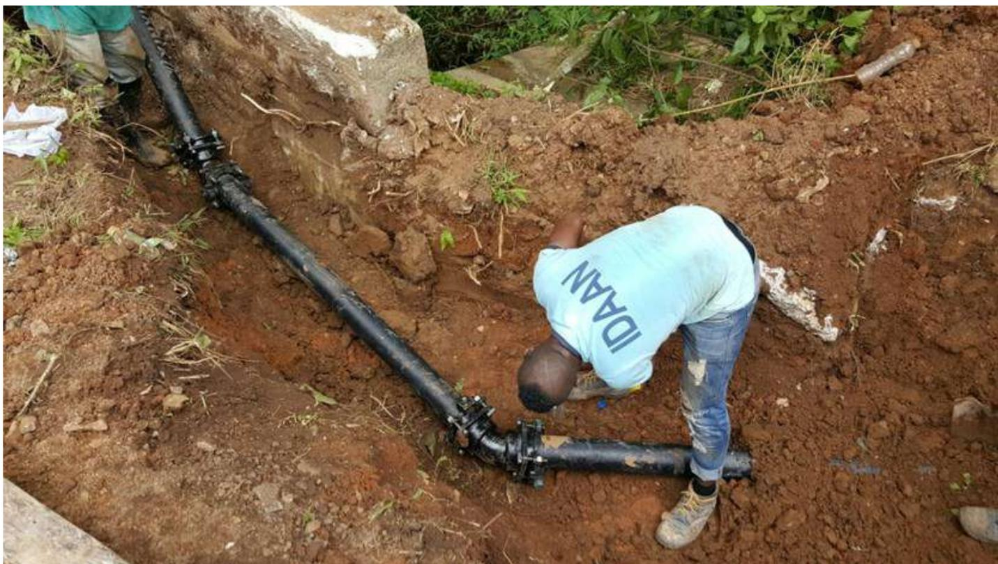
**Trabajos de mejoras en los cruces de ríos y quebradas de Arraiján para evitar que con el cambio climático se afecte la tubería de agua por inundaciones.**
