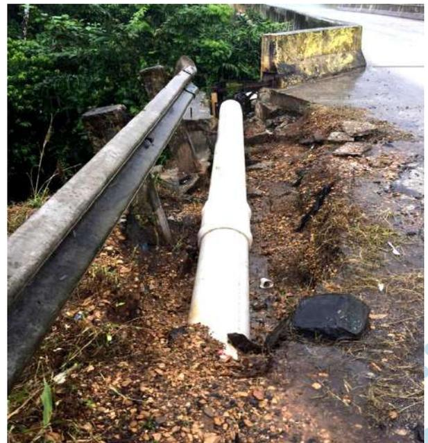
**Refuerzos para la confiabilidad de accesorios instalados en la línea de conducción de 12" de pvc que proviene de la estación de bombeo de Santa Rita Arriba.**
