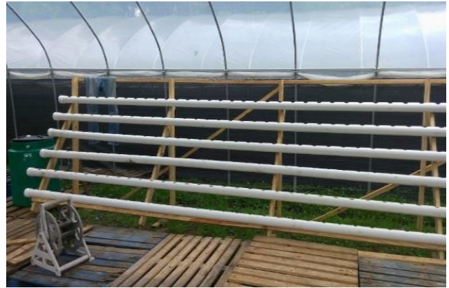
Construcción de vivero hidropónico
