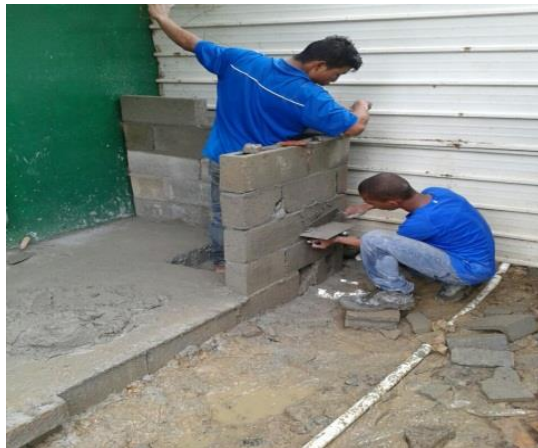
CTI Construcción, Penonomé
