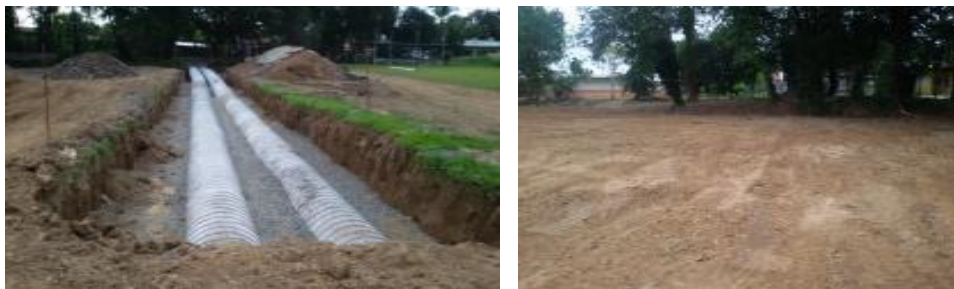
Canalización de las Aguas Residuales del Centro Regional de Bocas del Toro
