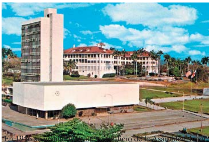
En 1956 se inauguró el edificio de la Asamblea Nacional, donde funciona en la actualidad.
