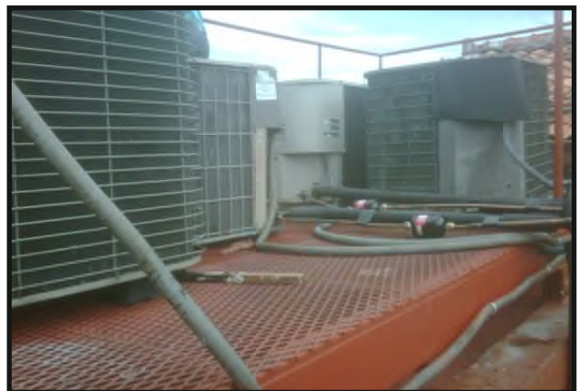
Labores de mantenimiento, remplazo del techo y confección de base metálica para condensadores de los aires del despacho superior.
