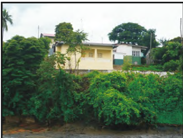
Construcción de Casa de Hospedaje de Saboga B/. 63,000.00
