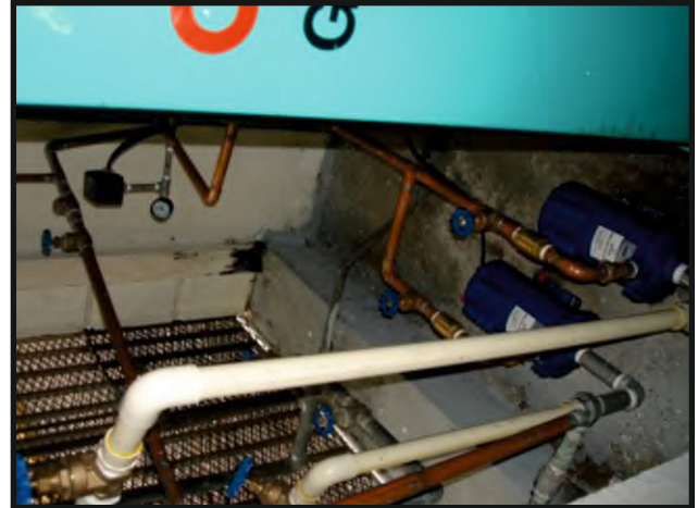
Dos bombas de agua nuevas para el palacio
