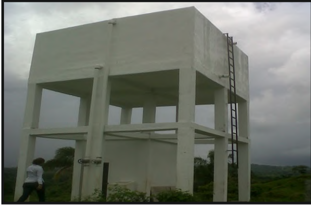
ACUEDUCTO DE CUIPO EN COLÓN
