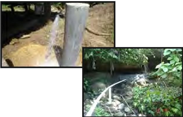
Construcción de Acueducto Quebrada Limón B/. 28,056.00
