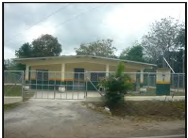
“Mejoras al Sub-centro de Salud de Gira”, Distrito Colón, Corregimiento Buena Vista Monto B/. 52,400.00
