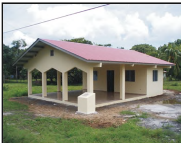
“Construcción de Casa Comunal en Ave María”, Corregimiento de Guánico, Distrito de Tonosí , Provincia de Los Santos.
