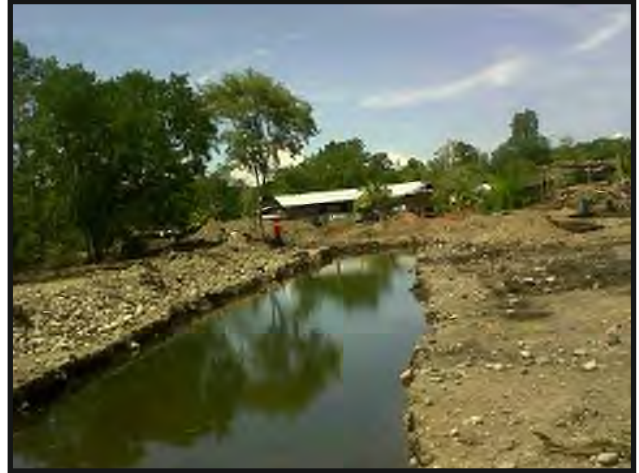
Tratamiento de Aguas Servidas mediante Humedales Artificiales en Chiriquí Grande
