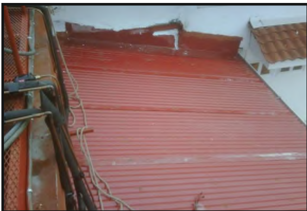
Labores de mantenimiento, remplazo del techo y confección de base metálica para condensadores de los aires del despacho superior.
