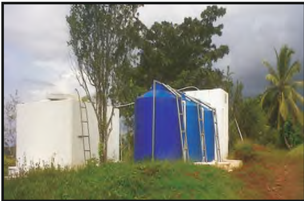
ACUEDUCTO DE EL PEPINO EN COLÓN
