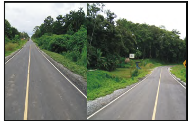
TRAMO V CARRETERA PANAMERICANA- DARIÉN
