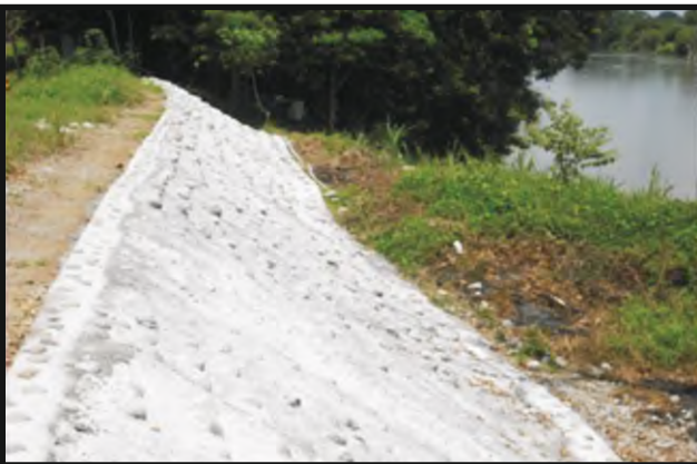
“Construcción del Muro de Contención del Río Chiriquí en Baco” Corregimiento de Baco Distrito de Barú Monto B/. 159,574.38
