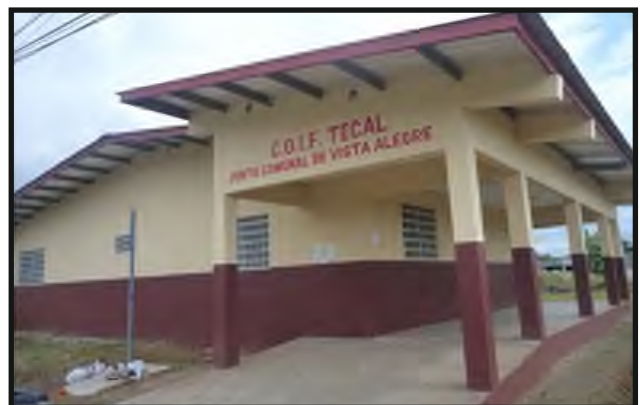
Construcción de COIF en el Tecal de Vista Alegre, Distrito de Arraijan B/. 79,985.20
