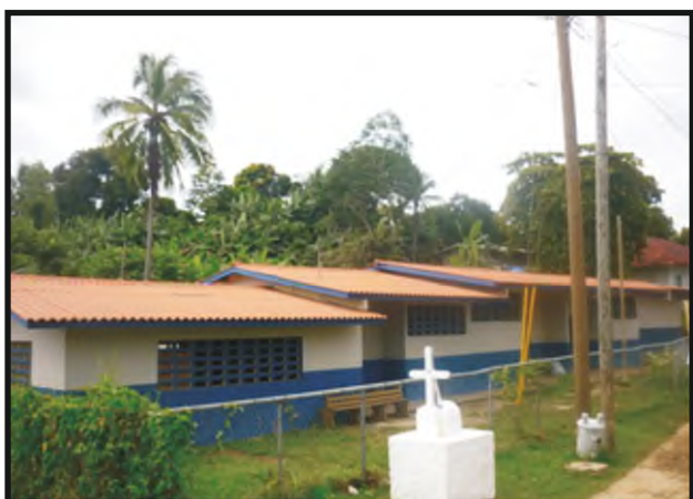
Reemplazo de techo e instalación de cielorraso, incluye la colocación de puertas, equipamiento de informática adecuación de la cocina, ampliación del pasillo, sistema eléctrico y construcción del Comedor. B/.85,000.00
