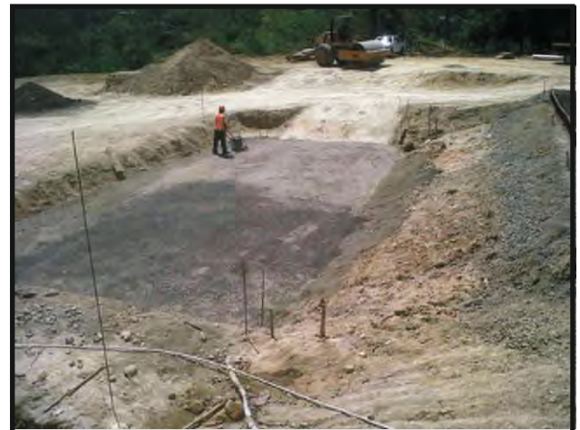
CONSTRUCCIÓN DE LA PLANTA POTABILIZADORA DE ALMITANTE EN BOCAS DEL TORO
