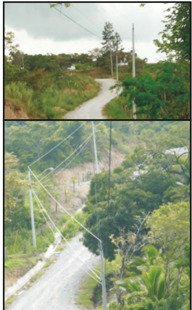
Línea eléctrica construida en la comunidad de Chichivalí, en San Carlos.
