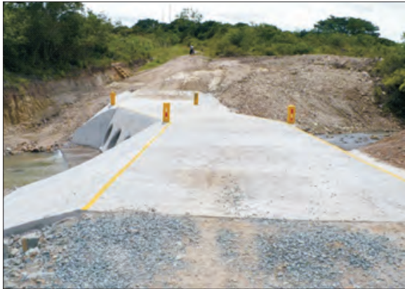
Proyecto 2326. Coclé, Antón, Juan Díaz Construcción de 2 Vados en el Corregimiento
