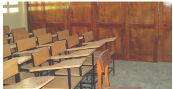
Construcción de tres Aulas para: Laboratorios de Informática, Química y Física CEBG Cerro Pelado Cerro Pelado, Ñurum, Comarca Ngöbe Buglé Monto B/.71,702.
