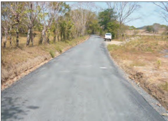
Proyecto 1471. La Tablas, Palmitas. Rehabilitación de Calles Internas de Las Palmas.
