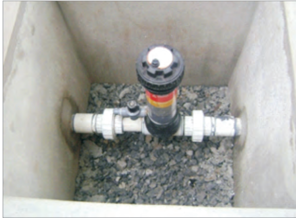
Proyecto 2039. Veraguas, Río de Jesús. Construcción de Acueducto en Cerro Gordo.
