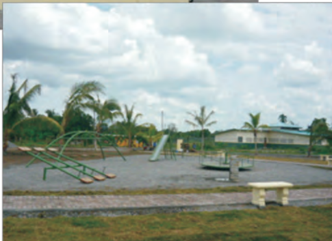
Proyecto 2363. Chiriquí, Alanje. Construcción del Parque Recreativo de El Tejar.
