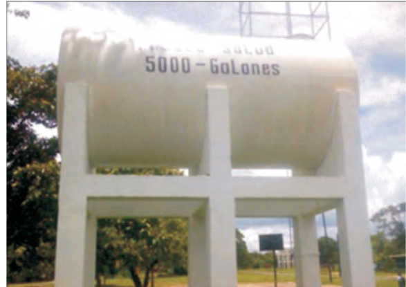
Proyecto 2114. Veraguas, Soná, Soná. Mejoras al Acueducto de la Comunidad de San José.
