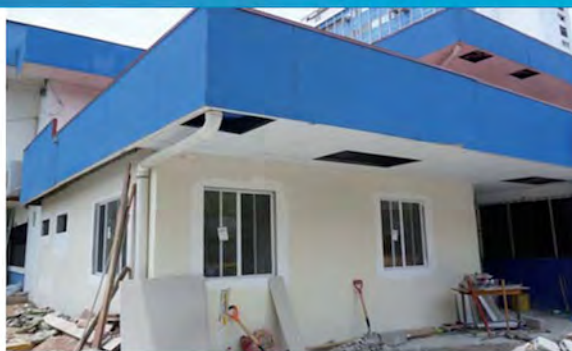
Construcción de la sede de la Comisión de Credenciales
