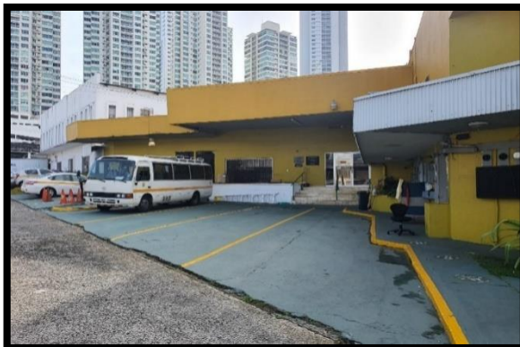
Pintura de los estacionamientos del IPACOOOP, sede de Planta Central
