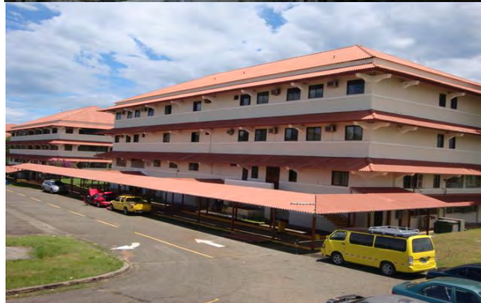
Reparación del cobertizo en el Centro Regional de Colón
