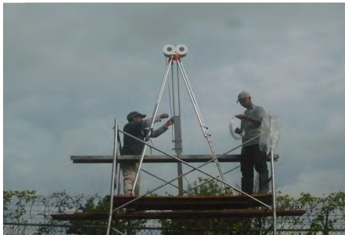
Instalación de Centillómetro en Tocumen
