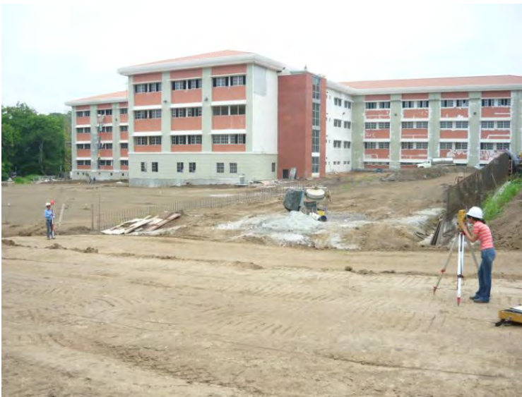
Inicio de los trabajos de construcción del Estacionamiento del Edificio No.3
