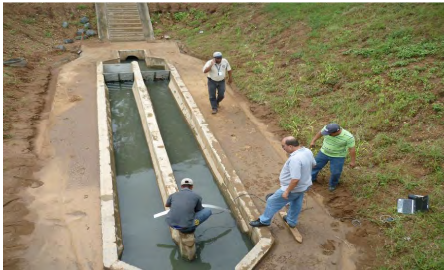
Inspección al proyecto de Alcantarillado de la Villa de Los Santos
