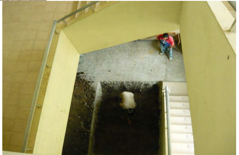
Trabajo del Ascensor del Edificio No.1
