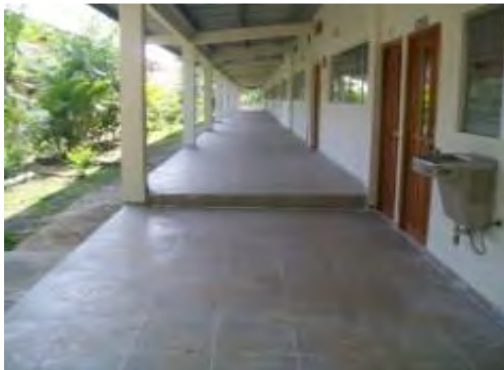
Colocación de baldosas, Edificio “D” del Centro Regional de Azuero
