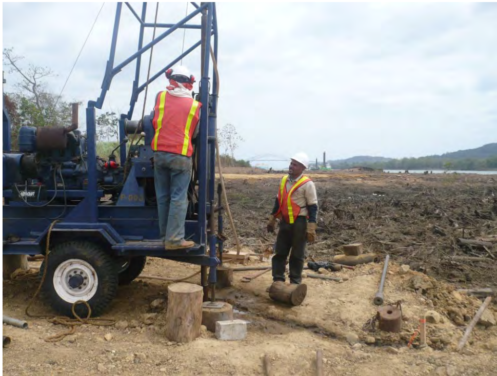
Pruebas de suelo para tercer juego de esclusas del Proyecto de Ampliación del Canal
