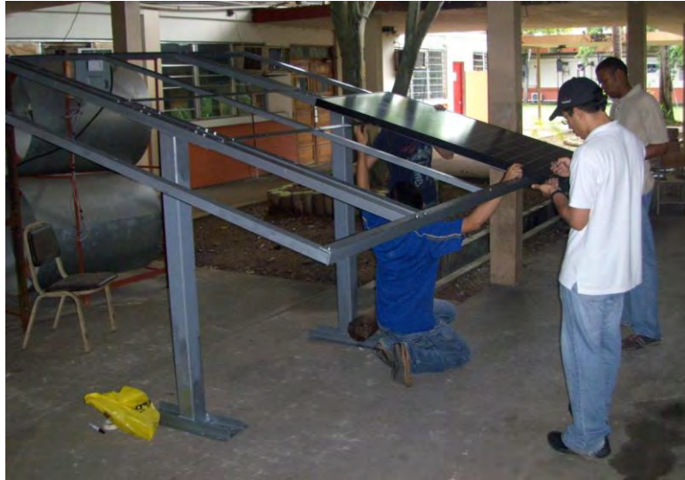
Pruebas a la estructura de los paneles fotovoltaicos a instalar en la comunidad de Boca Lurá, Coclé.
