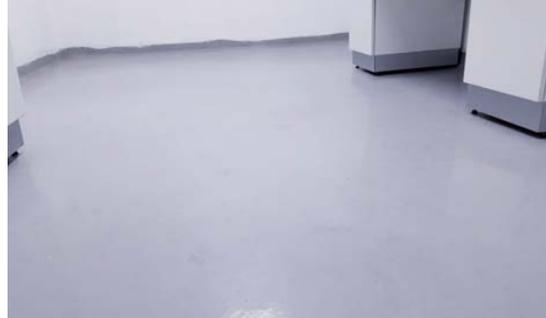
Revestimiento con sistema de mortero epóxico para piso.
