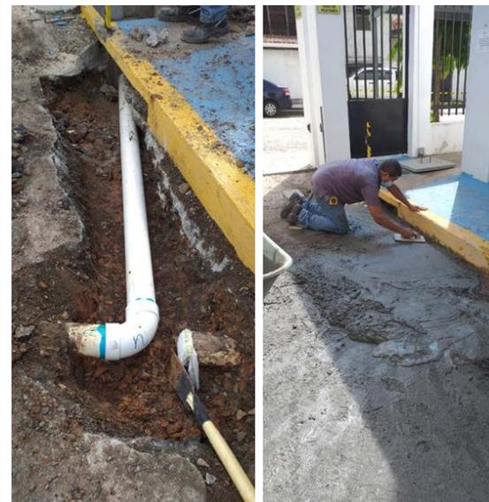
Reemplazo de tubería de desagüe de la caseta de desechos peligrosos.
