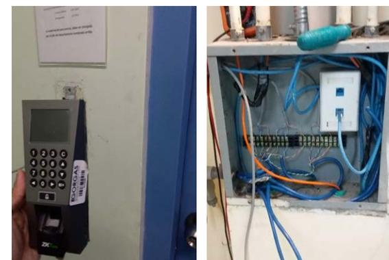
Integración de Controladora InBio 460, verificación de esclavamiento y conexión de dispositivos en el laboratorio COVID-19 (BSL-3).
