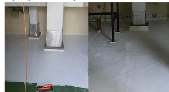
Mantenimiento del cuarto de máquina del laboratorio BSL-3 del departamento, ubicado en la azotea del Edificio Pedro Galindo del Gorgas. Segunda fase: aplicación de la primera capa de polímero.
