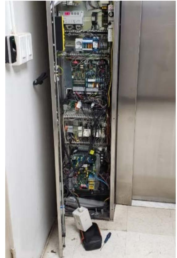
Instalación del variador de frecuencia para el elevador del Edificio de Investigaciones.
