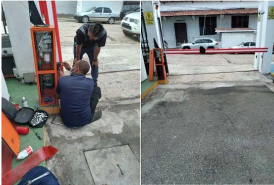
Kit de articulado y ajustes, asta, balance, lubricaciones y ajuste de fotoceldas.
