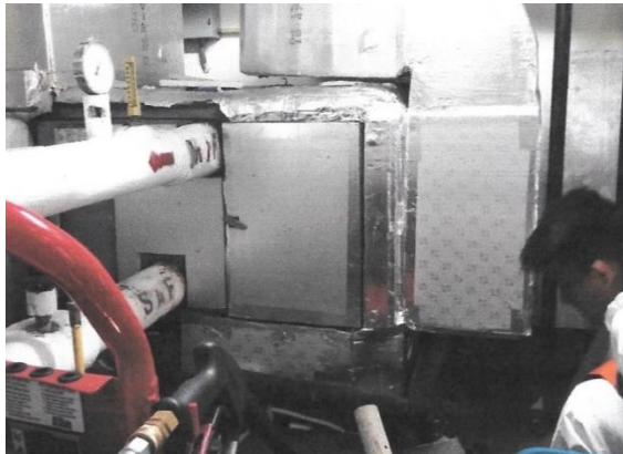
Cambio de aislamiento de la manejadora de aire del laboratorio BSL3.
