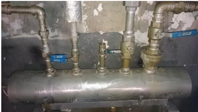
Dispositivos de medición y control (termómetro, válvula de bola, manómetro, válvula reguladora de vapor) suministrados e instalados por la empresa para un control general.
