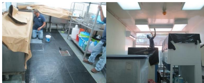
Adecuaciones de áreas para disminuir los riesgos
