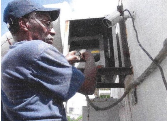
Cambio del motor del extractor del área del laboratorio del BSL-3
