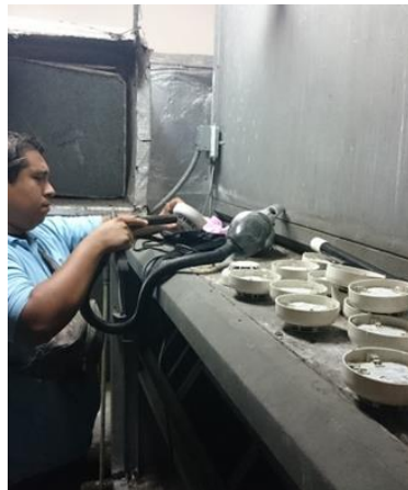
Desmote y limpieza de los detectores de humo en el LCRSP
