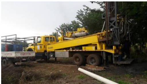
Maquinaria para la perforación del pozo de agua potable
