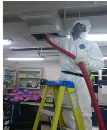
Limpieza en los ductos de aire en el LCRSP.
