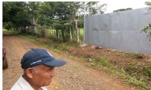
Construcción del portón entregado en Divisa
