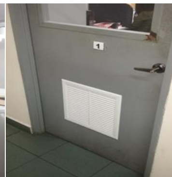
Colocación de parrillas de retorno de aire en puertas
