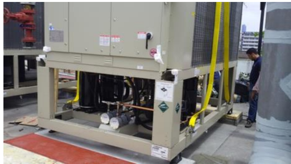
Instalación del Chiller en la azotea del LCRSP
