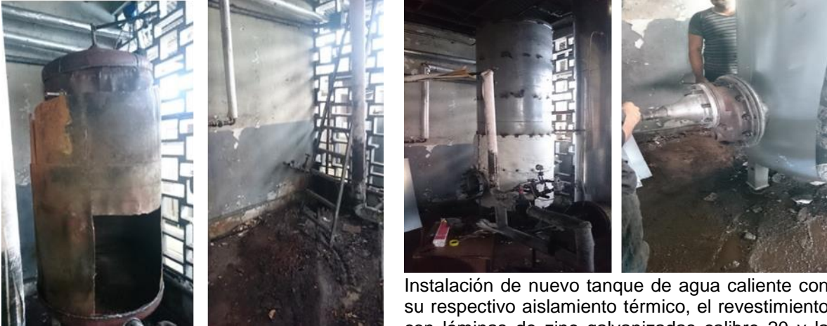
Desmantelación del tanque viejo de vapor
