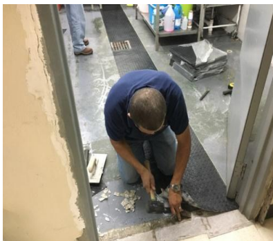
Instalación de alfombra de caucho
