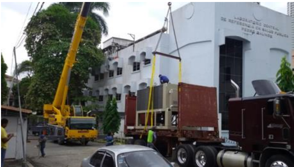
Levantamiento del Chiller para la azotea
