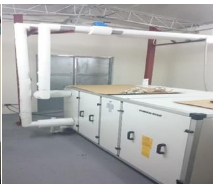
Instalación de la manejadora de aire
