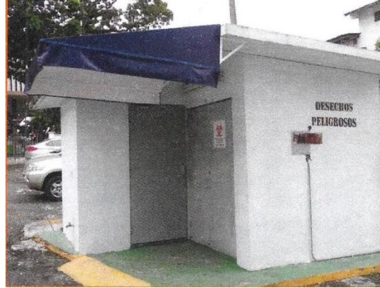
Adecuación de la caseta de desechos peligrosos.
