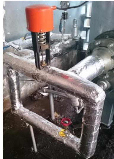
Dispositivos de medición y control (termómetro, válvula de bola, manómetro, válvula reguladora de vapor) suministrados e instalados por la empresa para un control general.
