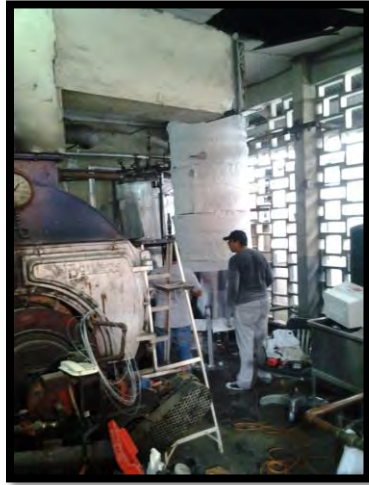
Nuevo tanque de agua caliente con su respectivo aislamiento térmico y el revestimiento con láminas galvanizadas calibre 20.
