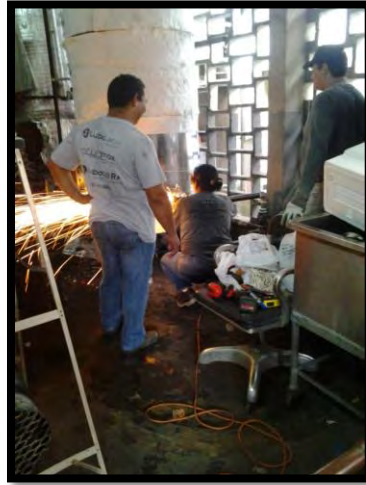
Nuevo tanque de agua caliente con su respectivo aislamiento térmico y el revestimiento con láminas galvanizadas calibre 20.
