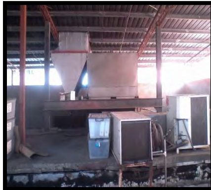
Este AIRE compacto de 30 toneladas Y adicional una unidad de 5 toneladas.
