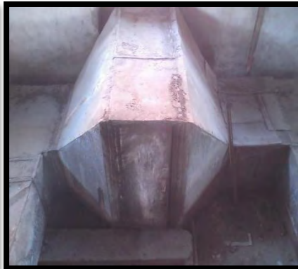
Hay que reemplazar la caja de filtro. MUY OXIDADO.
